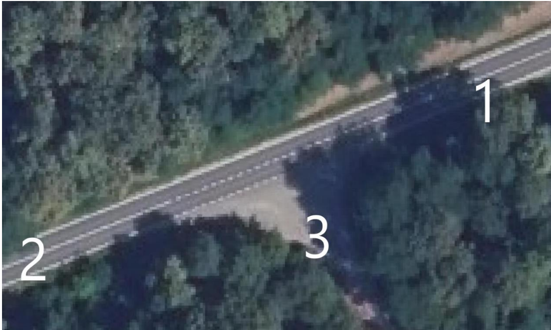
Slika 16. DOF snimka sjevernog priključka planirane D1 i postojeće D1
