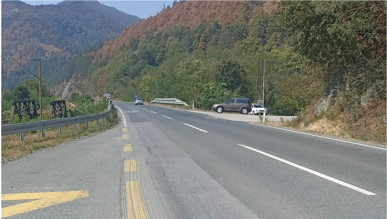
Slika 23. Pogled sa sjeverne strane
