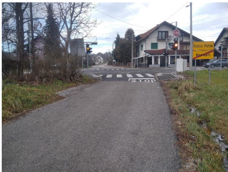
Slika 27. Raskrižje Stara Karlovačka cesta - Okićka ulica - Slemenska cesta (smjer Slemenska cesta) [Izvor: izradio autor]
