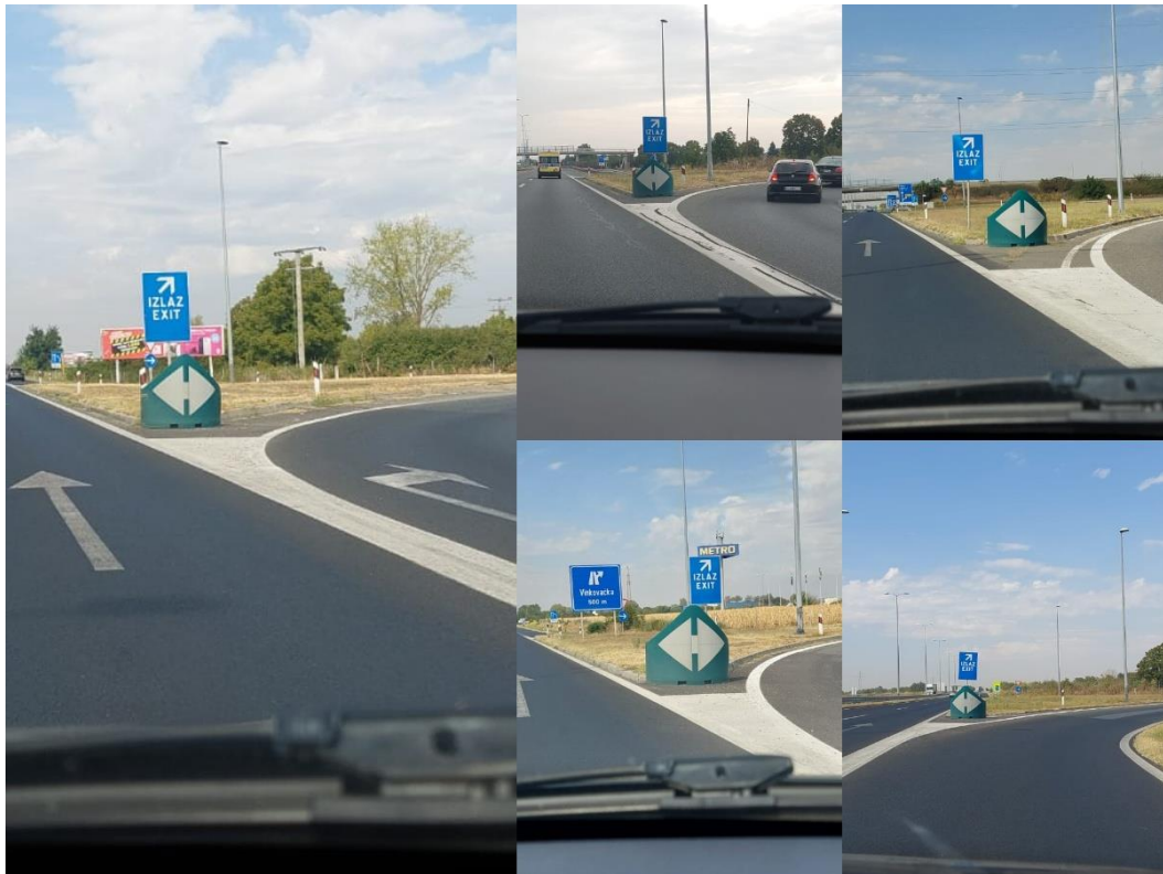
Slika 34. Nepravilno postavljena prometna oprema K06
