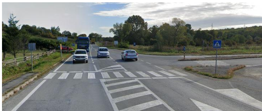
Slika 47. Trenutno stanje na raskrižju
