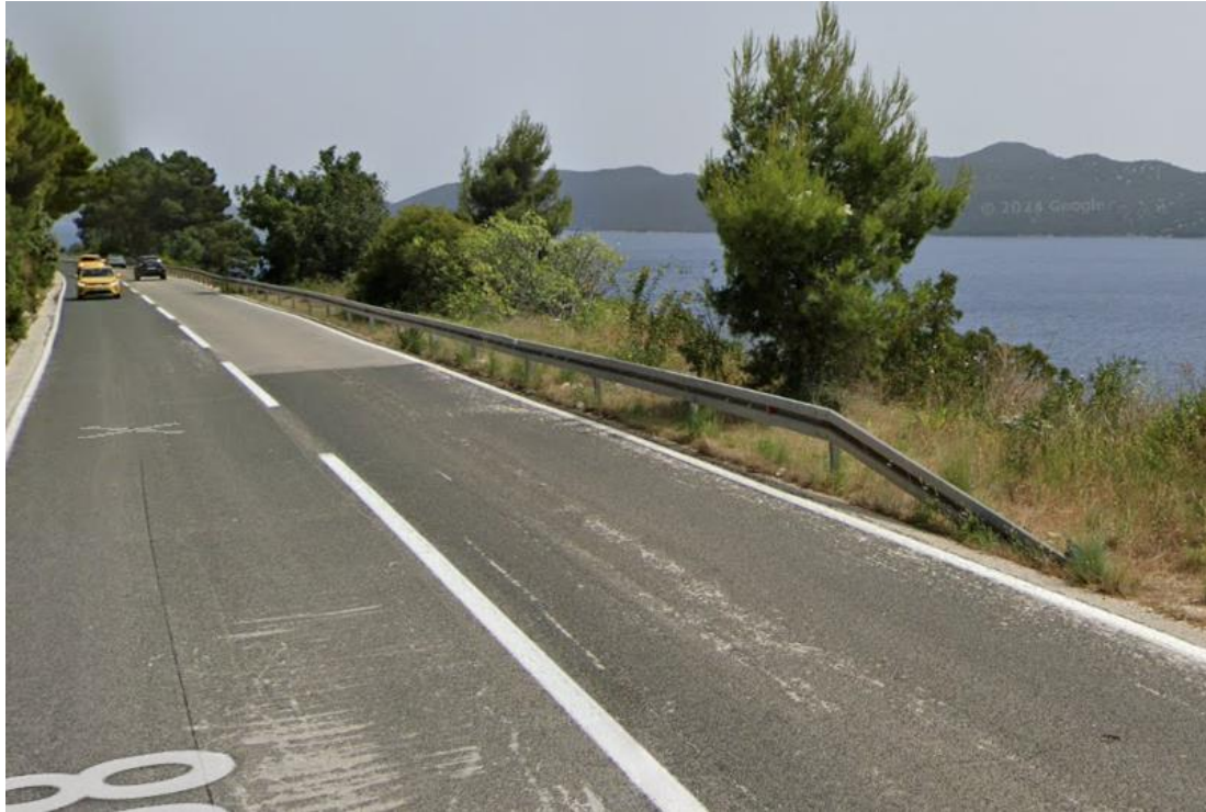
Slika 16. Ispravno izveden završetak/početak čelične zaštitne ograde - Primjer 3 Izvor:[23]
