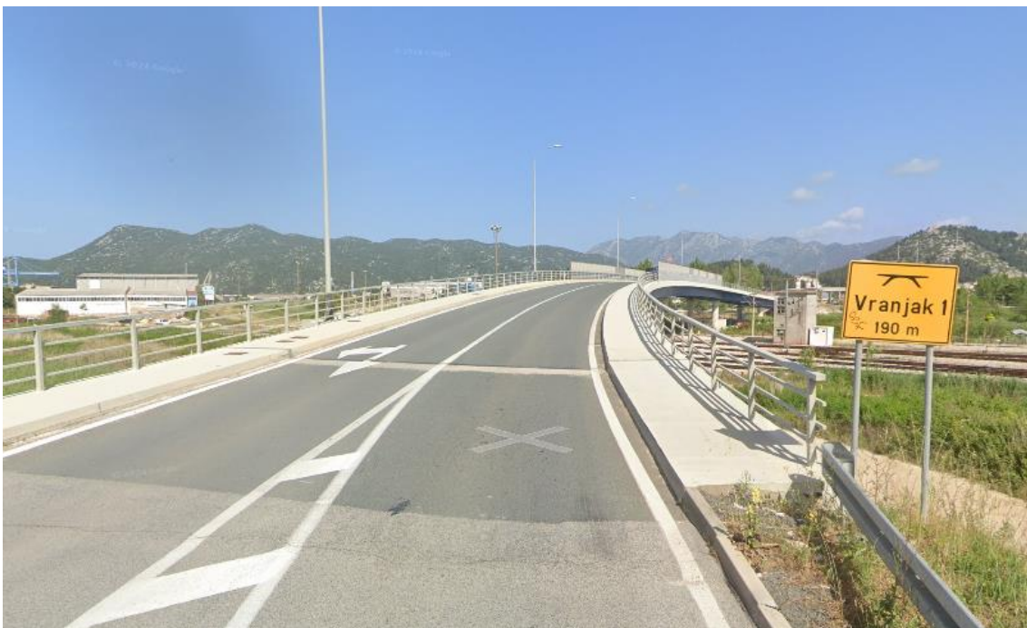
Slika 24. Neadekvatno zaštićen nogostup za kretanje pješaka– Primjer 2 Izvor:[23]
