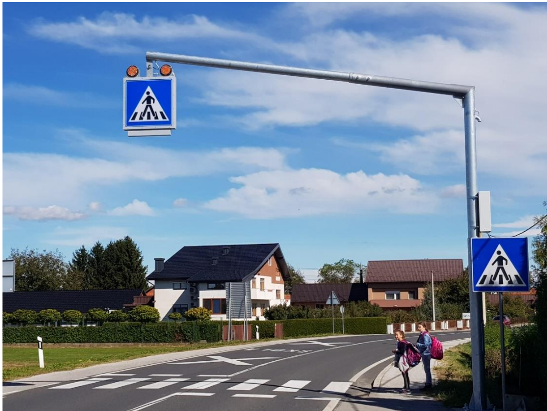
Slika 34. Primjer pješačkog prijelaza opremljenog SPZ-C02 na T portalu Izvor:[27]
