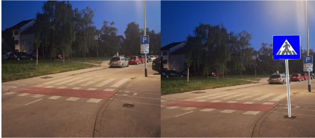
Slika 46. Postavljanje prometnog znaka „C02“
