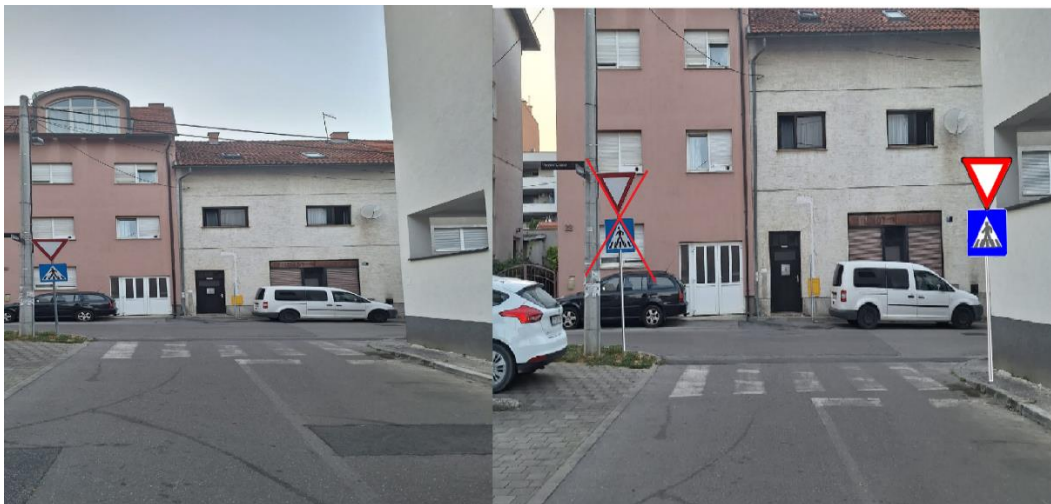
Slika 47. Postavljanje prometnog znaka s desne strane kolnika
