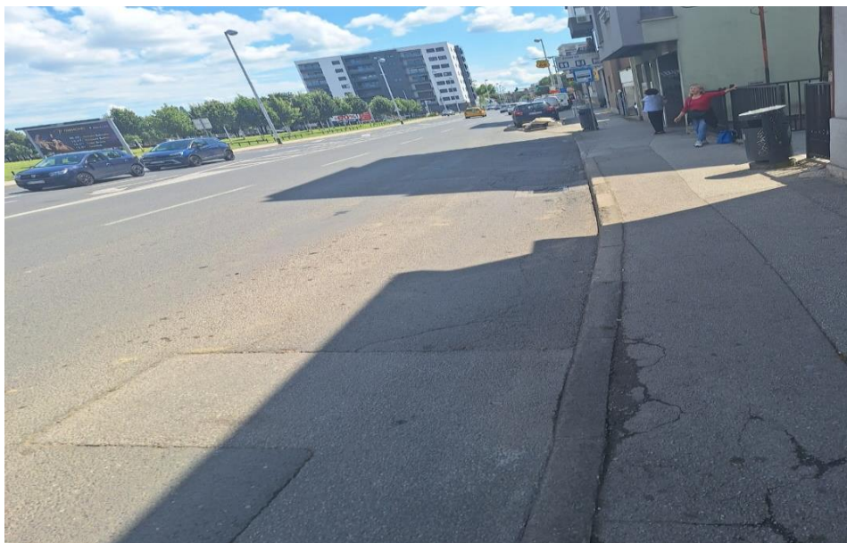
Slika 37. Izbledjene oznake za obilježavanje autobusnog stajališta
