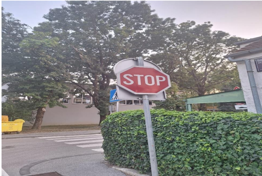
Slika 60. Neadekvatno postavljen prometni znak
