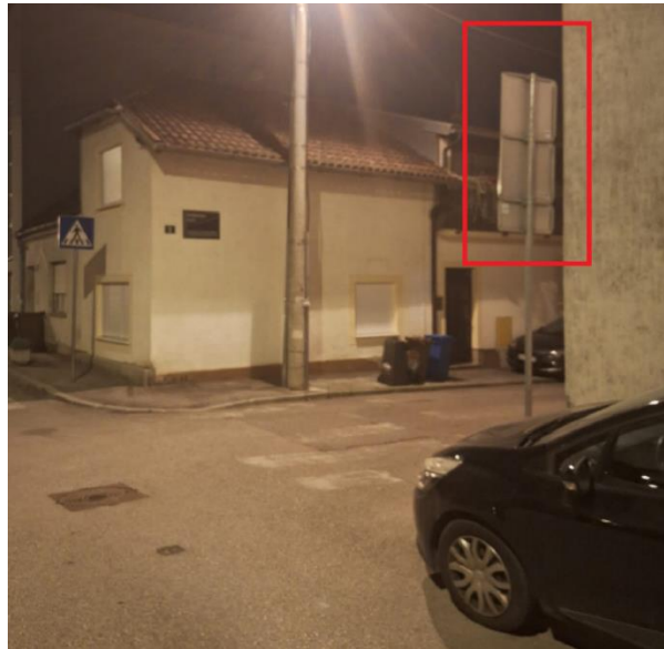
Slika 31. Primjer neadekvatno postavljenog prometnog znaka
