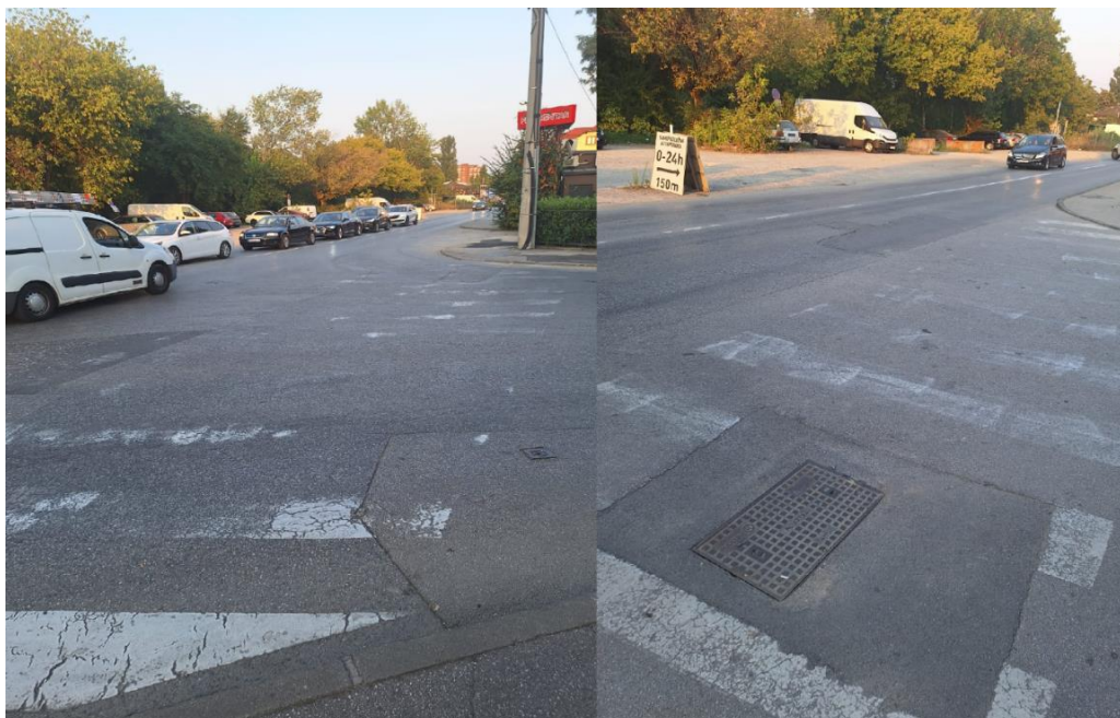
Slika 55. Izblijeđena horizontalna signalizacija u Tomislavovoj ulici
