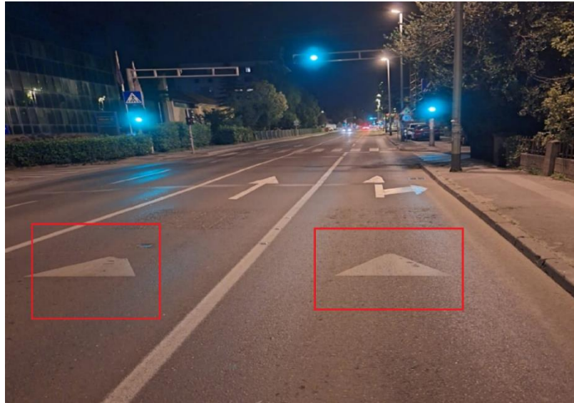
Slika 38. Primjer tragova prethodno izvedenih oznaka na kolniku
