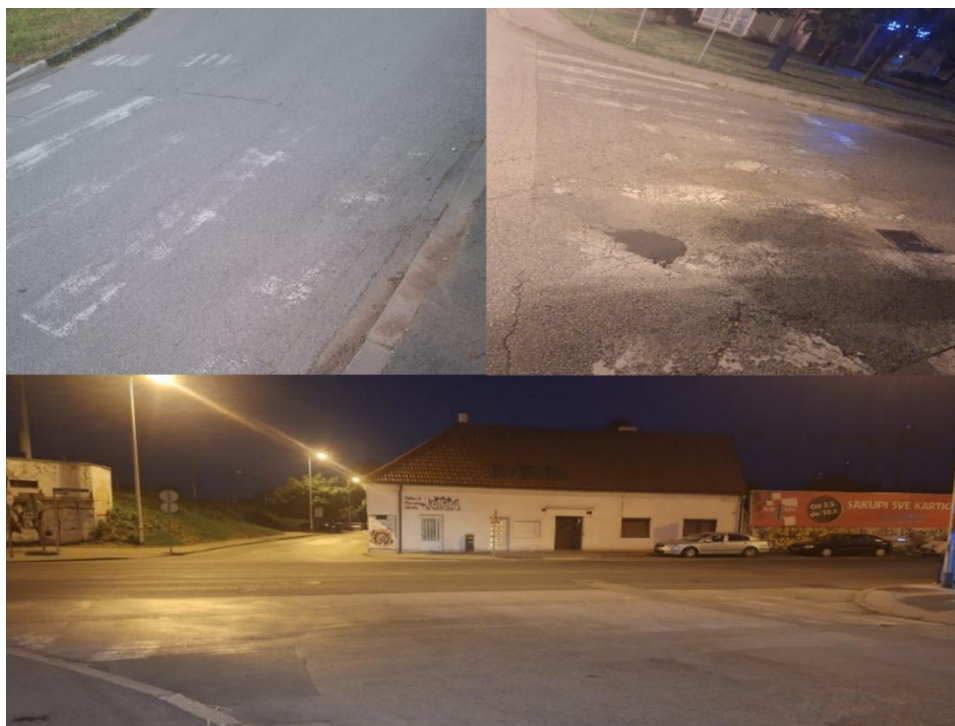
Slika 34. Primjeri izbledjenih pješaačkih prijelaza
