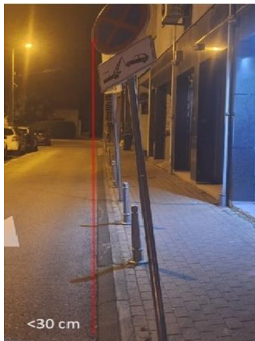
Slika 25. Primjer prometnog znaka na premaloj udaljenosti od ruba kolnika
