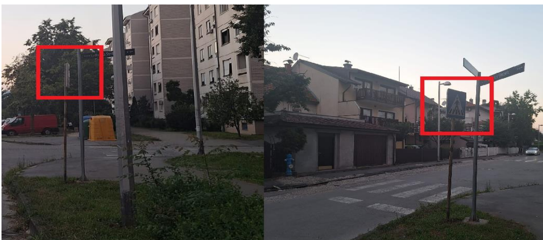
Slika 32. Neadekvatno postavljen prometni znak „C02“
