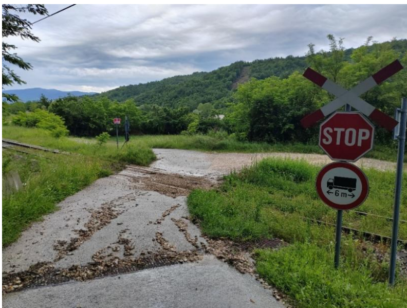
Slika 26. Željezničko-cestovni prijelaz Blagonići 1 iz smjera sjevera
