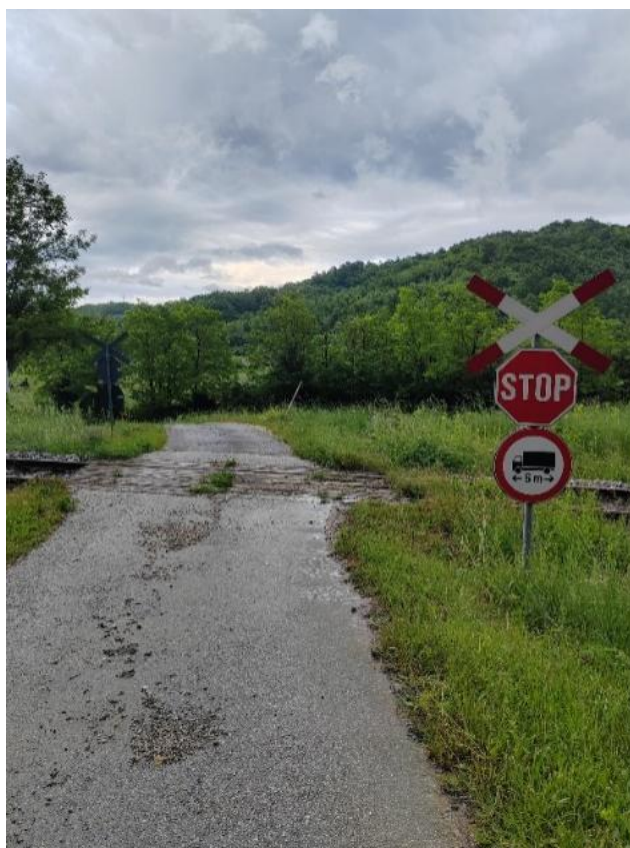
Slika 24. Željezničko-cestovni prijelaz Orlovići iz smjera sjevera
