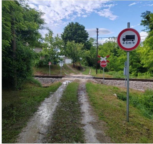
Slika 42. Željezničko-cestovni prijelaz Dubravica
