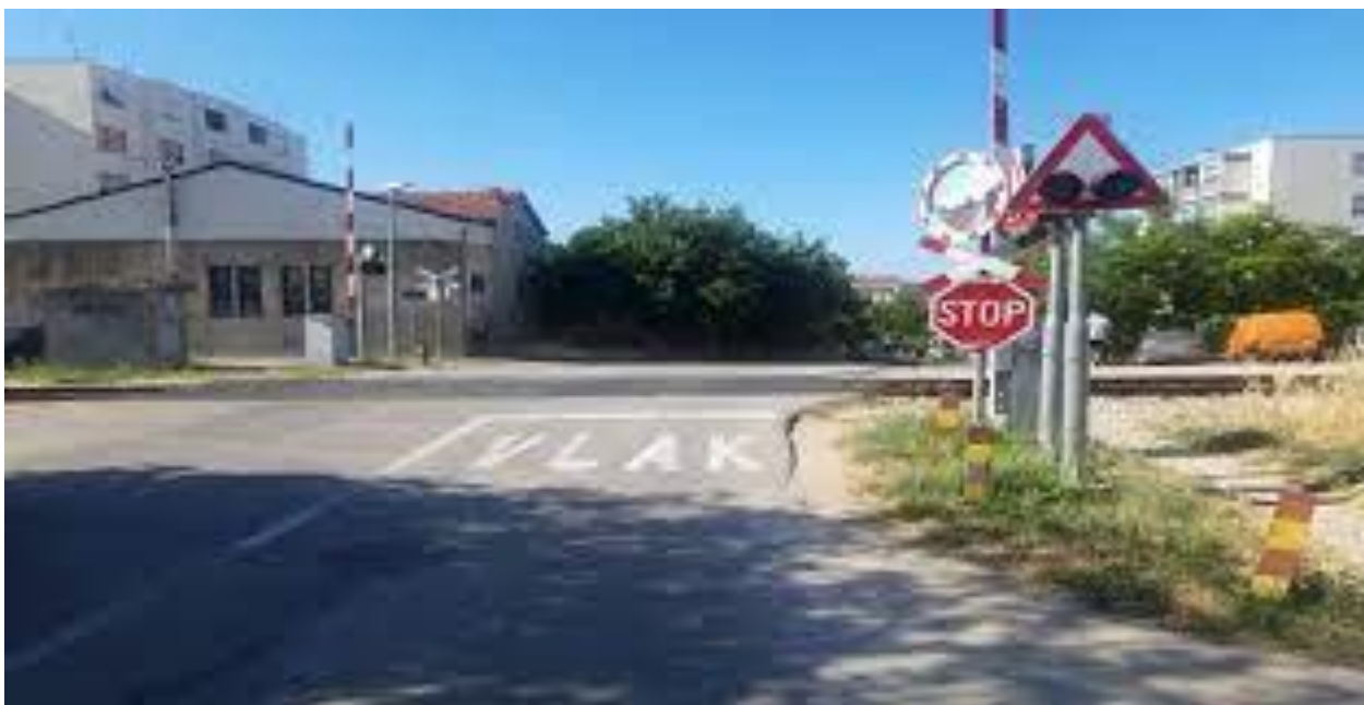
Slika 4. Pasivno osiguran željezničko-cestovni prijelaz [3]
