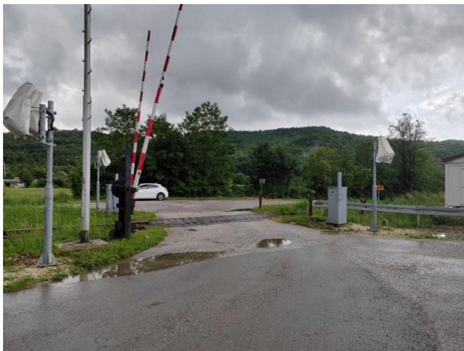
Slika 22. Željezničko-cestovni prijelaz Borut 1 iz smjera sjevera
