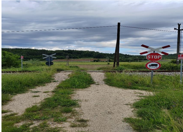
Slika 40. Željezničko-cestovni prijelaz Cerovlje 2
