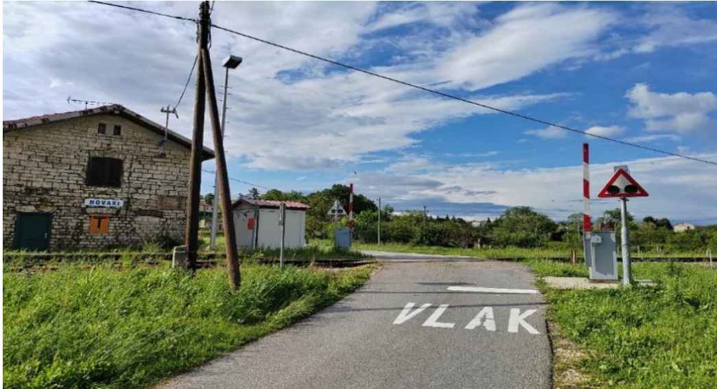
Slika 34. Željezničko-cestovni prijelaz Novaki iz smjera juga
