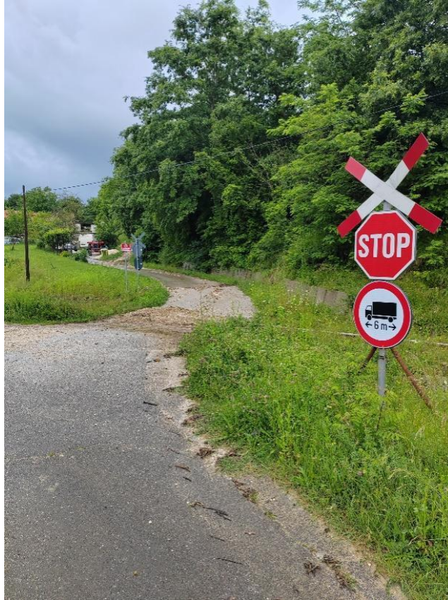
Slika 25. Željezničko-cestovni prijelaz Blagonići iz smjera juga
