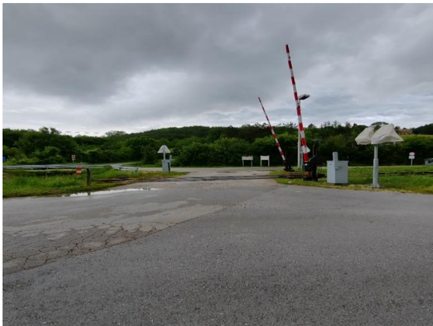
Slika 21. Željezničko-cestovni prijelaz Borut 1 iz smjera juga
