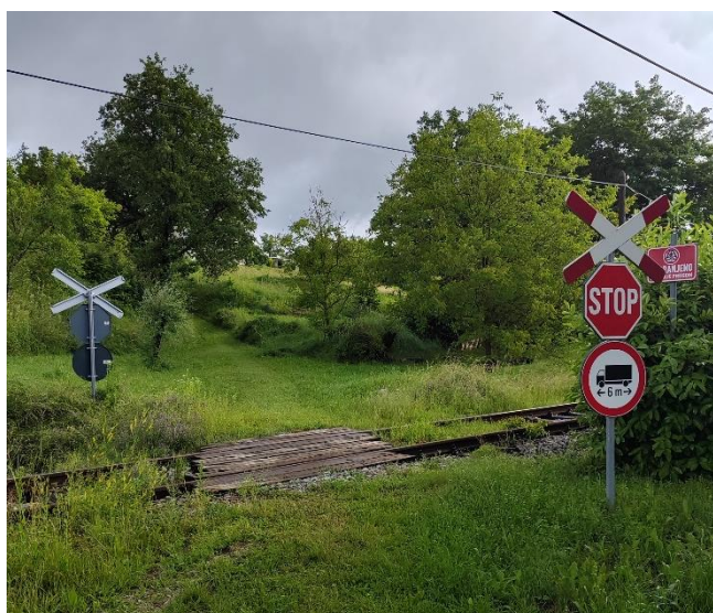
Slika 37. Željezničko-cestovni prijelaz Moloni
