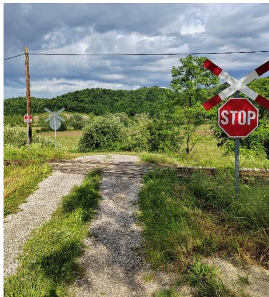
Slika 41. Željezničko-cestovni prijelaz Ćusi
