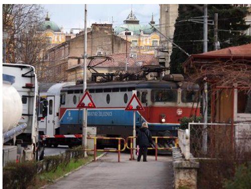
Slika 14. Pješački prijelaz sa svjetlosno-zvučnom signalizacijom i mimoilaznom ogradom za pješake, Rijeka [13]
