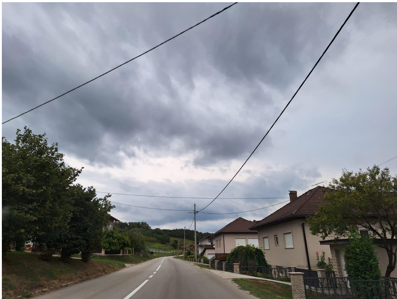
Slika 14 Nepostojanje biciklističkih i pješačkih površina na ŽC3185
