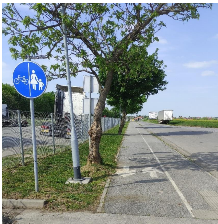
Slika 23. Pravilno izvedena vertikalna signalizacija u ulici Nikole Tesle
