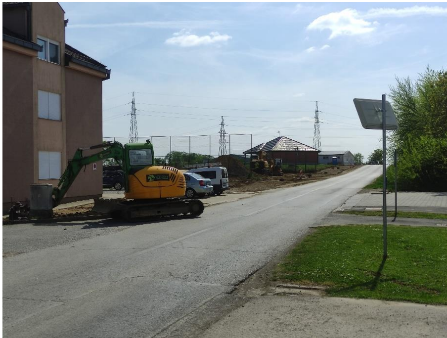
Slika 28. Radovi na izgradnji biciklističke staze u ulici biskupa Antuna Mandića
