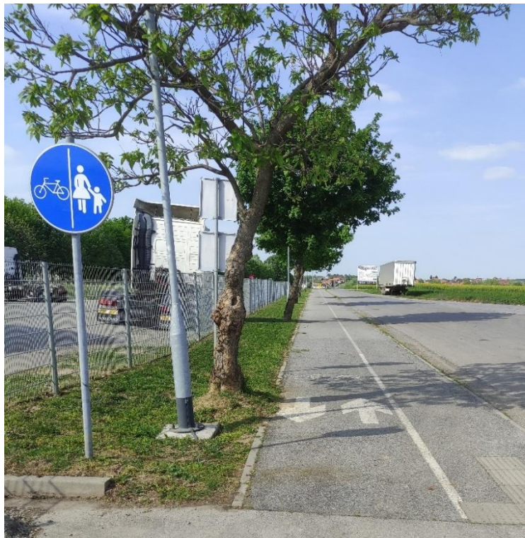
Slika 23. Pravilno izvedena vertikalna signalizacija u ulici Nikole Tesle
