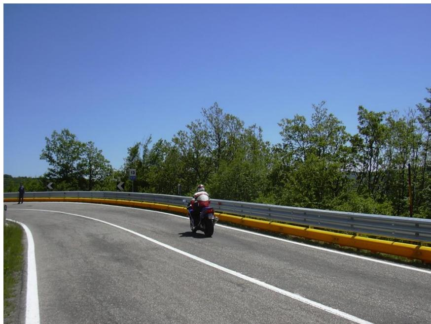
Slika 32. Dodatna zaštita od podljetanja na zaštitnoj ogradi, [16]
