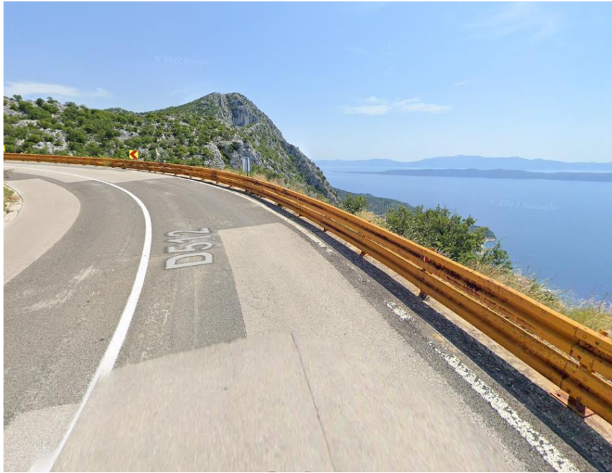
Slika 20. Izblijeđene rubne crte kolnika (niski stupanj)
