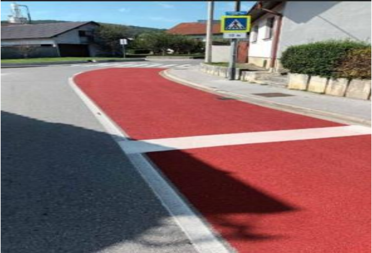
Slika 14. Protuklizna podloga na cesti
