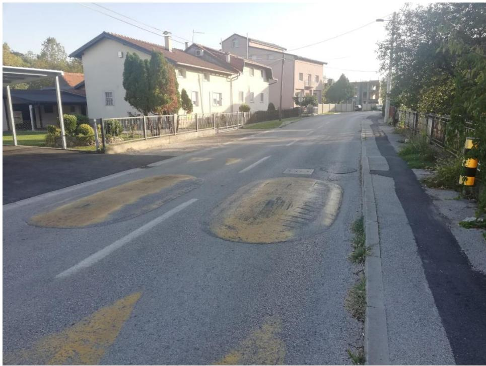
Slika 16: Betonski jastuci
