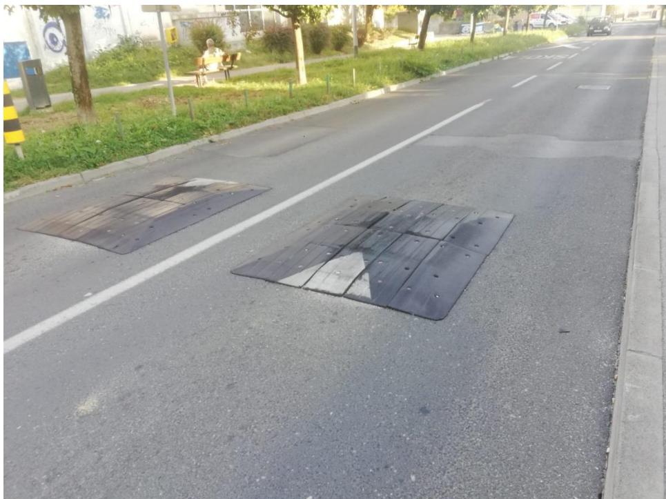
Slika 14: Četvrtasti uspornik prometa od reciklažne gume
