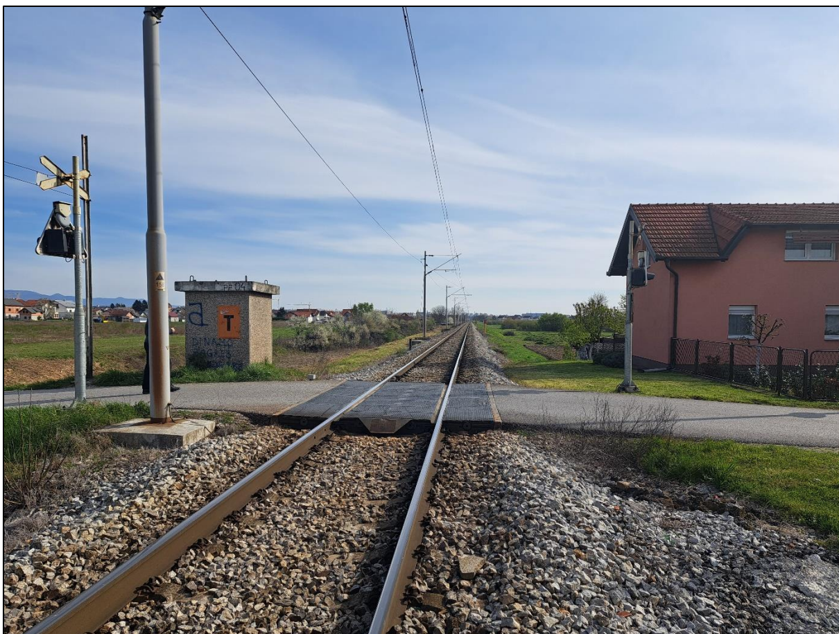
Slika 11. Željezničko - cestovni prijelaz 04 "Kata Mlinarić", smjer Hrvatski Leskovac - Zagreb GK
