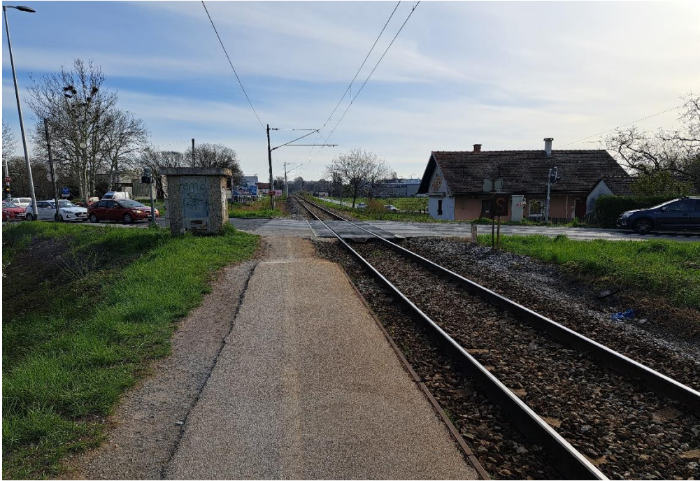
Slika 8. Željezničko-cestovni prijelaz 02 "Remetinec", smjer Hrvatski Leskovac - Zagreb GK
