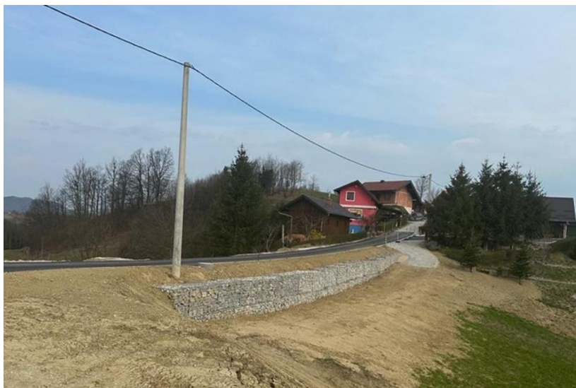
Slika 14: Sanacija klizišta u naselju Cvetlin, općina Bednja
