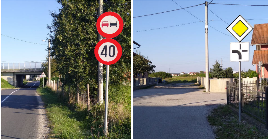
Slika 44. Prikaz obnovljenih prometnih znakova
