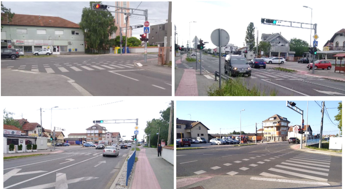
Slika 38. Pješački prijelazi i biciklističke staze na glavnom raskrižju prometnica DC3 i DC29
