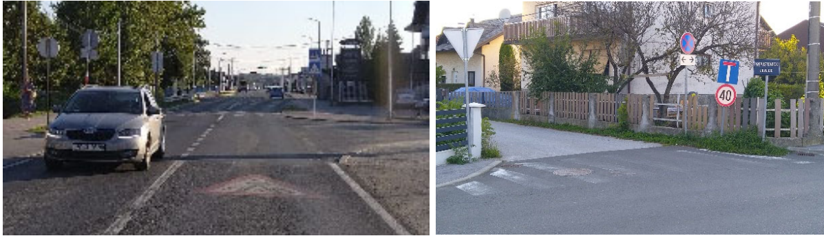
Slika 39. Prikaz oznaka na kolniku koje su izbljedile
