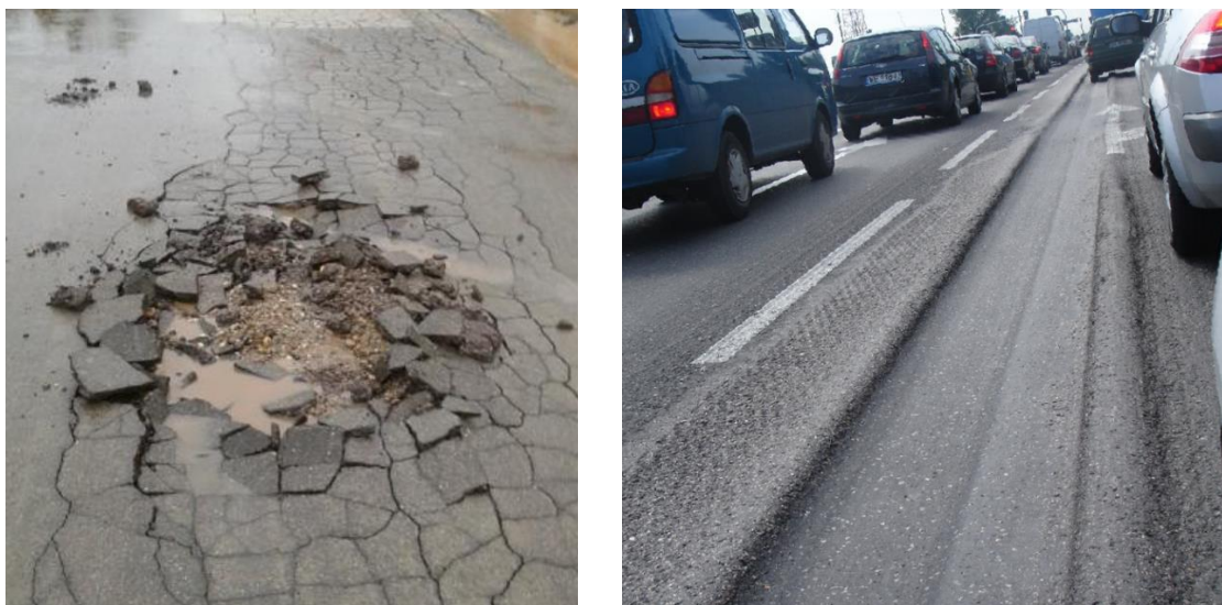
Slika 9. Primjeri stanja kolnika koji dovode do nastanka prometnih nesreća u kojima sudjeluju vozači motocikala
