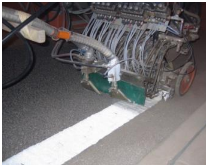
Slika 8. Nanošenje termoplastičnog materijala na kolnik [2]
