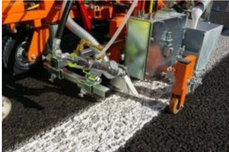
Slika 10. Nanošenje hladne plastike na kolnik [2]
