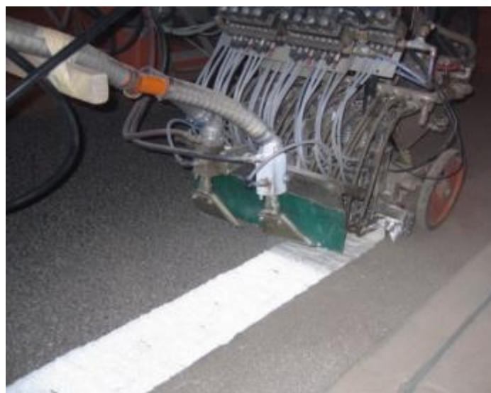
Slika 8. Nanošenje termoplastičnog materijala na kolnik [2]
