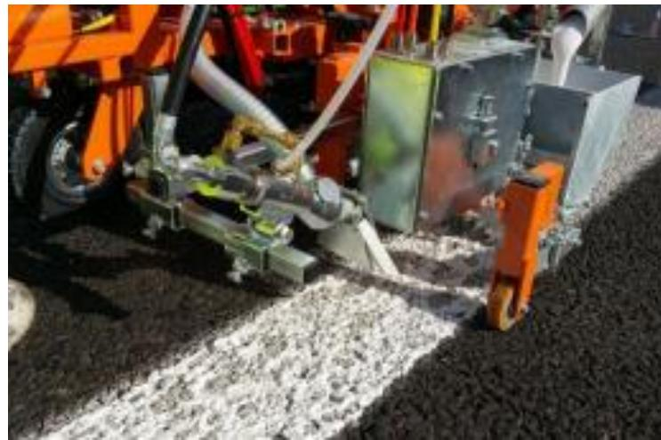
Slika 10. Nanošenje hladne plastike na kolnik [2]
