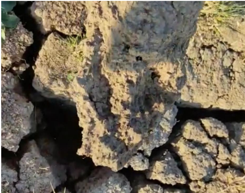
Slika 18.: Oštećenje na stazi za voženje prouzrokovano sušom
