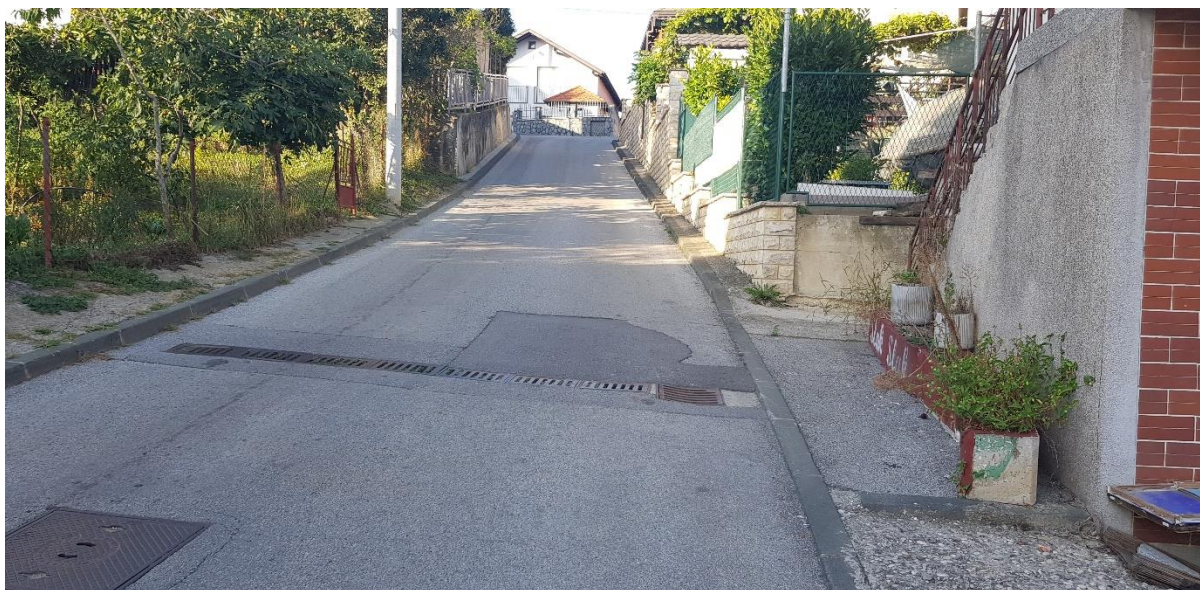
Slika 16. Uzdužni nagib veći od dopuštenog
