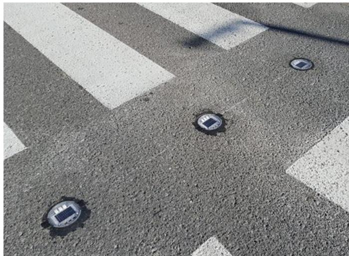
Slika 17. Solarni LED markeri, [38]
