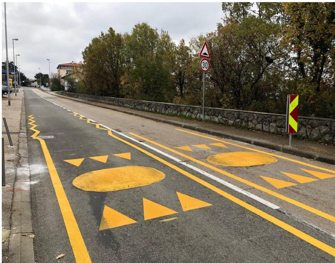
**Slika 29. Primjer betonskog usporivača prometa**
