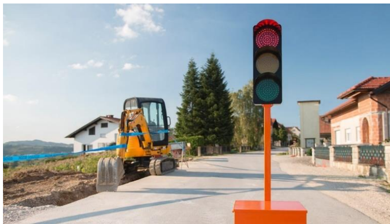
Slika 26: Mobilni semafor
