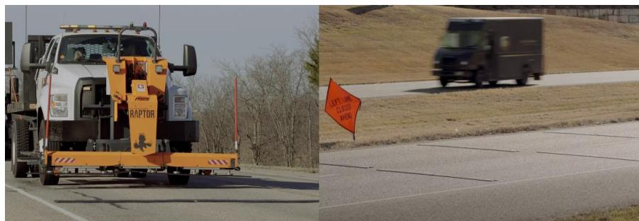
*Slika 34: Prijenosne trake za usporenje prometa*
