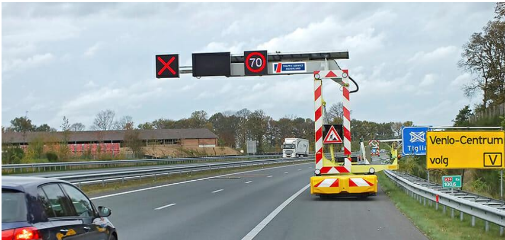
Slika 16: Prijenosna/mobilna prometna signalizacija
