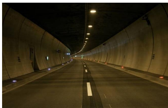
Slika 28: Smjerokazne oznake u tunelu
