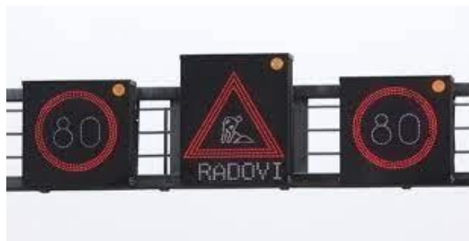
Slika 24: Svjetlosti promjenjivi znakovi
