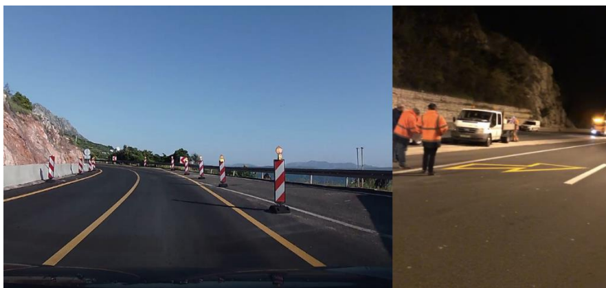
Slika 27: Privremene oznake na kolniku od trake
