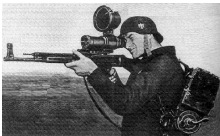
Slika 6. Njemački vojnik sa NVG sustavom "Vampir" [7]
