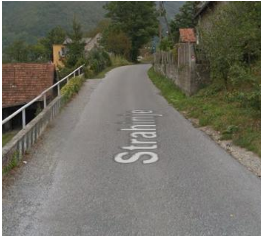
Slika 31. Kolnik nedovoljne širine
