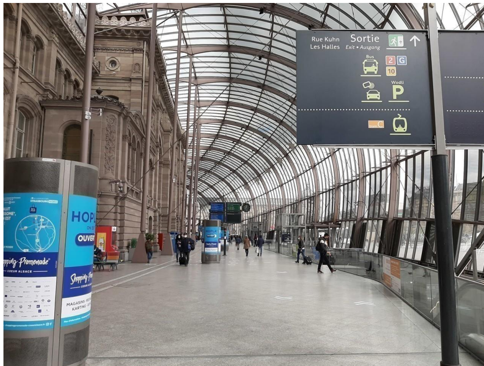
Slika 14. Željeznička postaja Gare de Strasbourg
