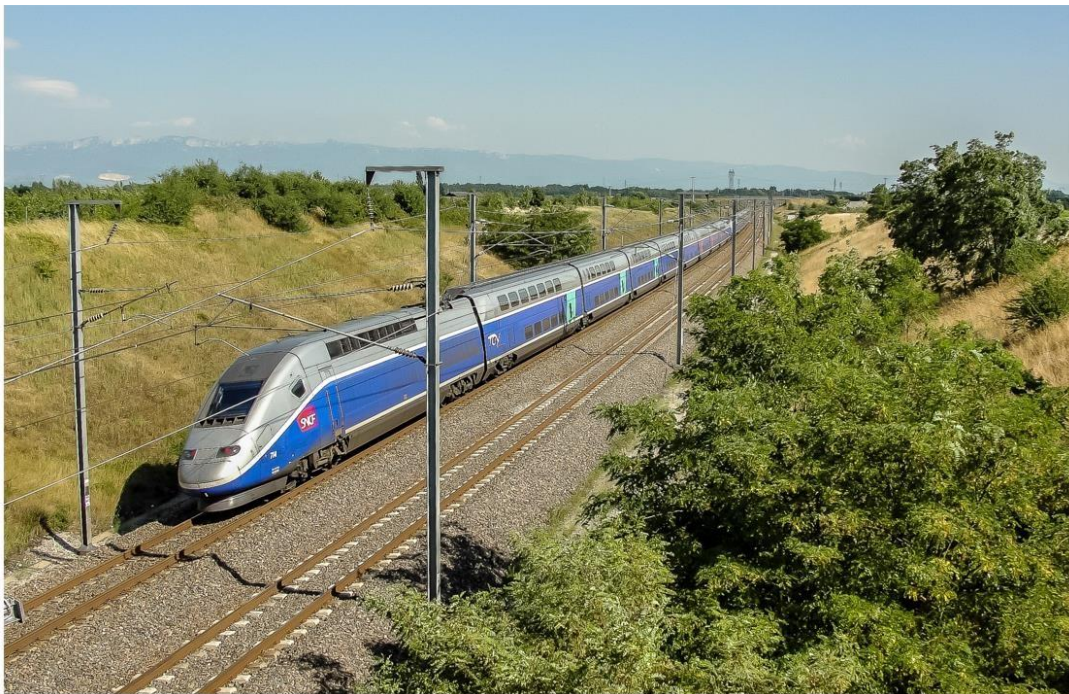
Slika 11. Kolosijek LGV željeznice na liniji Lyon-Marseille
