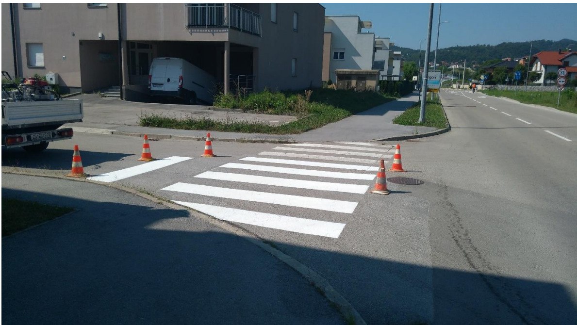
Slika 11. Obnova pješačkog prijelaza u Ulici Ivana Gundulića
