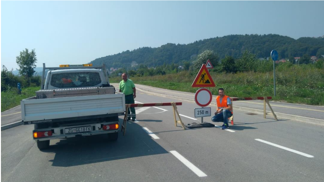
Slika 19. Postavljanje privremene regulacije prometa
