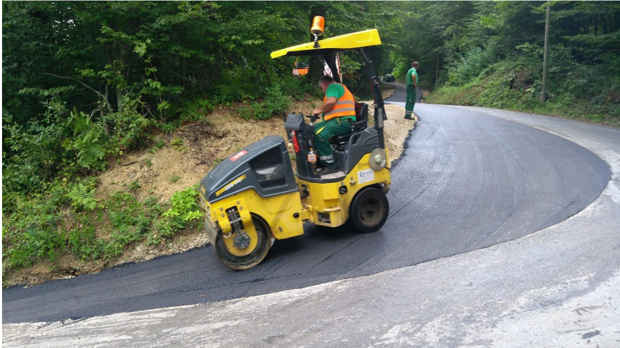
Slika 34. Završno zbijanje vibrirajućim valjkom
