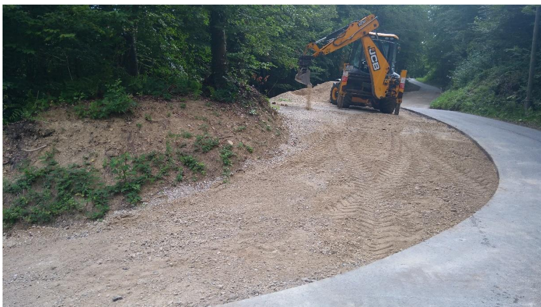
Slika 30. Priprema podloge
