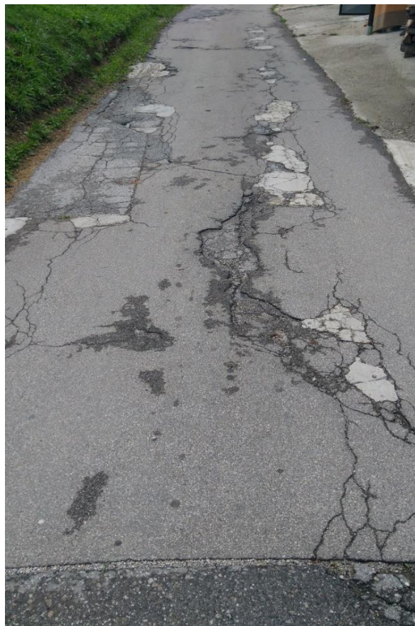
Slika 7. Pojava udarnih rupa u naselju Veliki Lipovec
