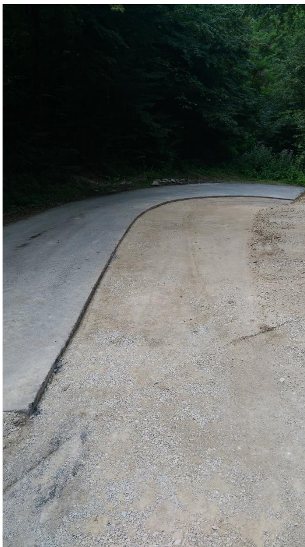
Slika 31. Podloga pripremljena za polaganje asfalta
