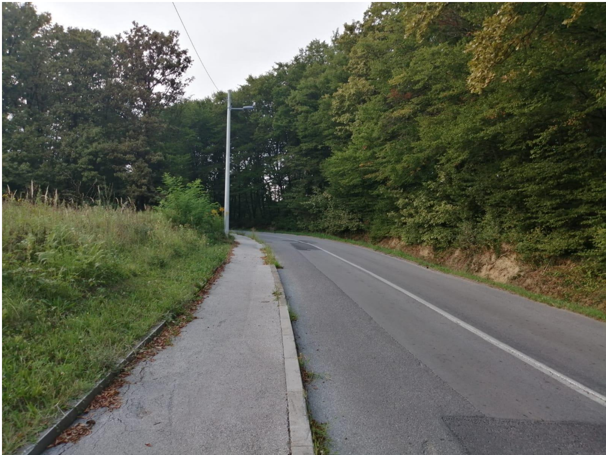
Slika 29. Slika zavoja s nagibom na vanjsku stranu zavoja
