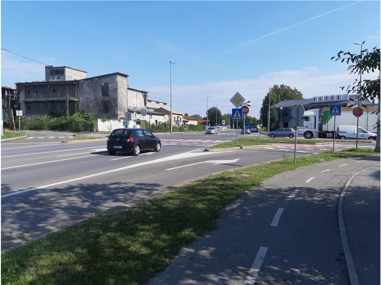
Slika 26. Raskrižje u Sisku sa prevelikim brojem prometnih znakova
