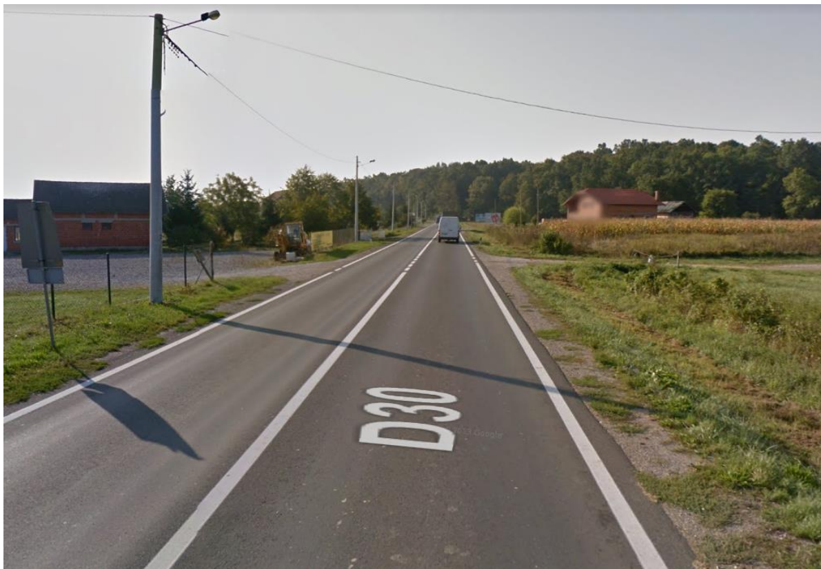
Slika 25. Nedostatak pješačke staze u naselju Žažina
