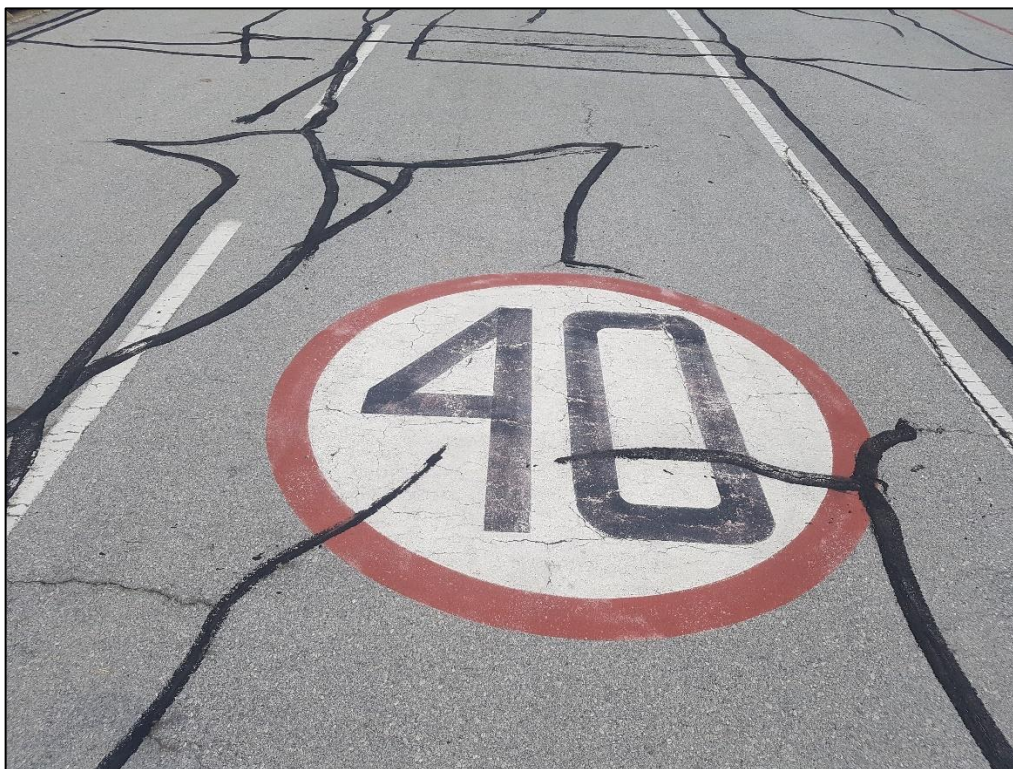
Slika 22. Horizontalna signalizacija Zračne luke Osijek
