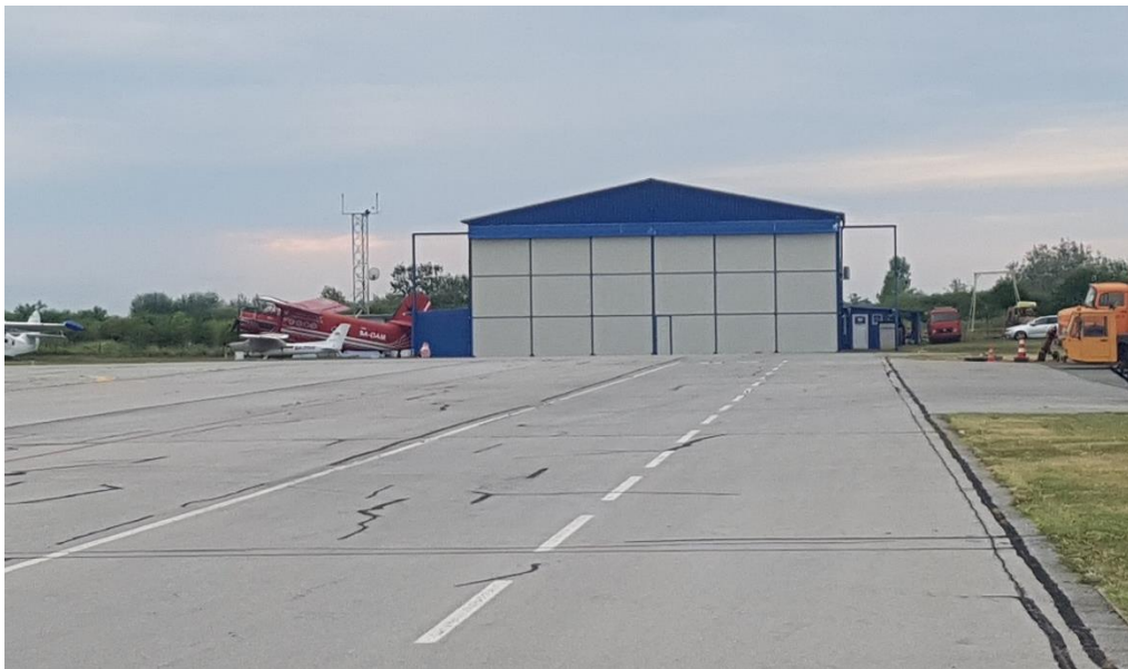
Slika 31. Hangar tvrtke Air Pannonia
