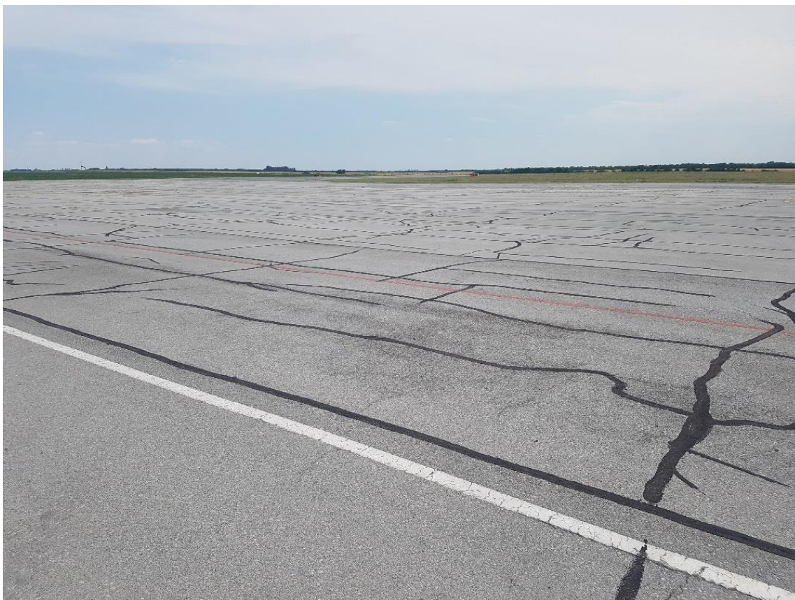
Slika 23. Linija razgraničenja (slaba vidljivost crvene linije)
