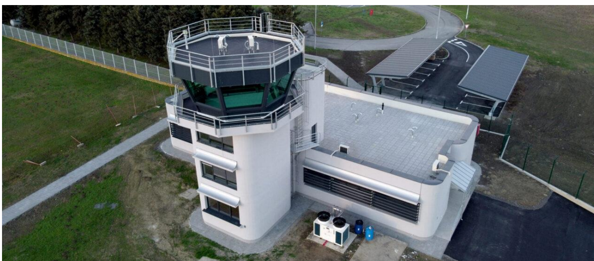
Slika 29. Kontrolni toranj zračne luke Osijek, [16]
