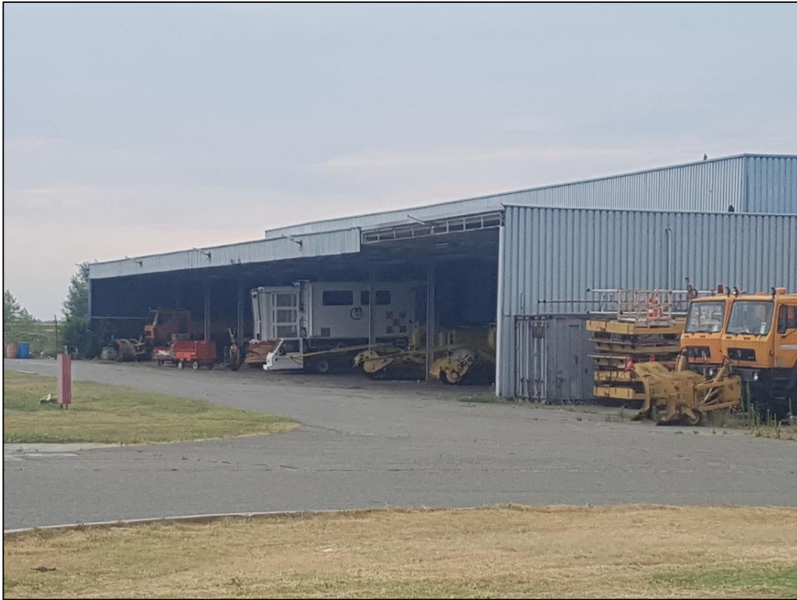
Slika 28. Prostor za parkiranje opreme ispred robnog terminala
