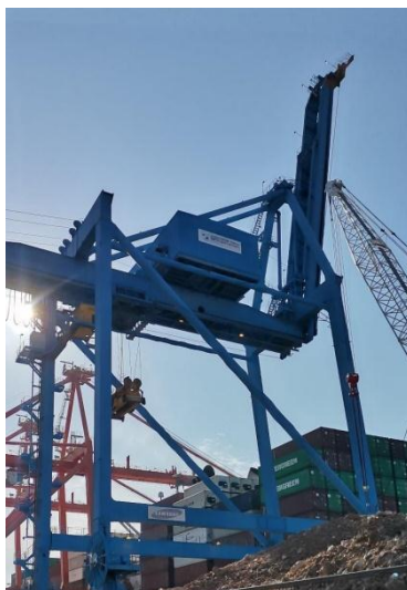
Slika 7. Panamax kontejnerska dizalica na terminalu Jadranska vrata
