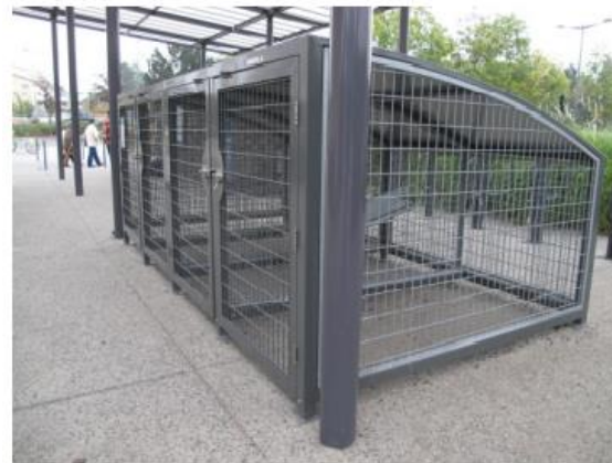
Slika 10. Parkirališta na otvorenom prostoru Izvor: [20]
