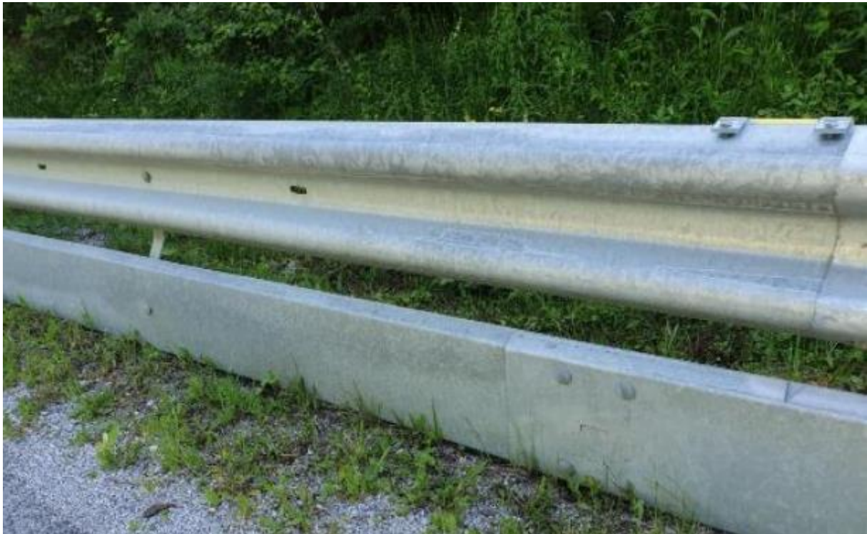
Slika 12. Zaštitna odbojna ograda s dodatnim elementom
