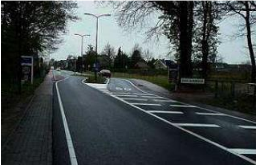
Slika 11. Način izvođenja cestovne infrastrukture na granici između naseljenog i nenaseljenog područja – primjena u praksi
