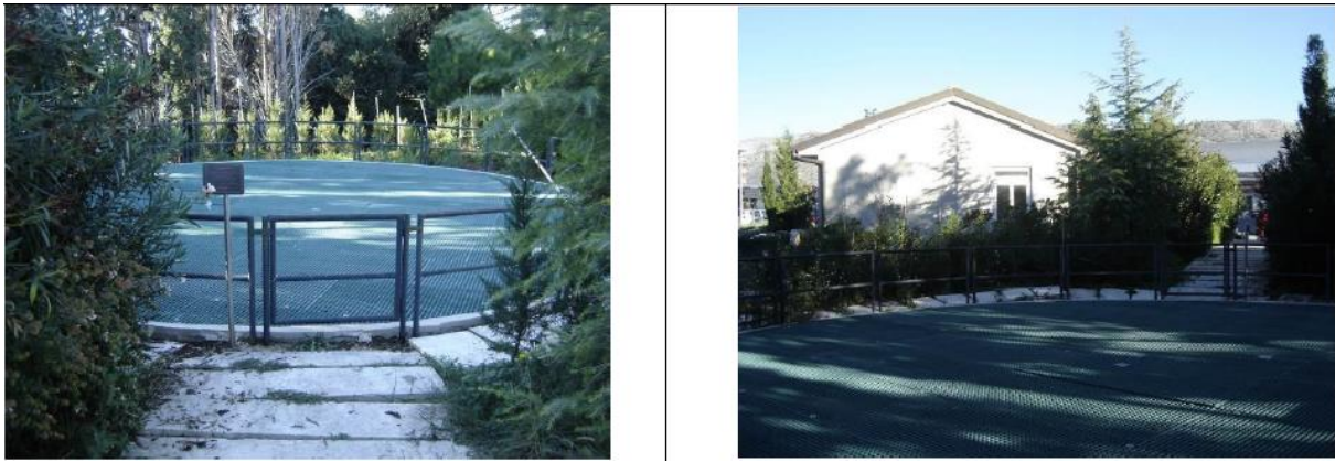
Slika 6. Uređaj i strojnica uređaja za pročišćavanje otpadnih voda na ZLD Izvor: Poljanec, Z., prof.biol.: Studija o utjecaju na okoliš za zahvat: Proširenje zračne luke Dubrovnik , općina Konavle, Zagreb, 2013., str.25.
