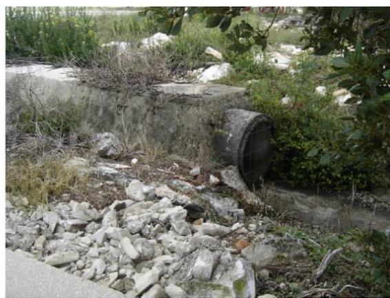
Slika 7. Cjevovod oborinske kanalizacije na istočnom kraju stajanke opće avijacije Izvor: Poljanec, Z., prof.biol.: Studija o utjecaju na okoliš za zahvat: Proširenje zračne luke Dubrovnik , općina Konavle, Zagreb, 2013., str.26.
