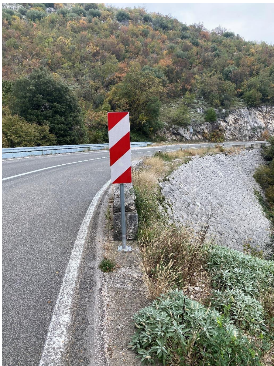
Slika 29. Ploča K12-1 za označavanje bočne zapreke (DC66)
