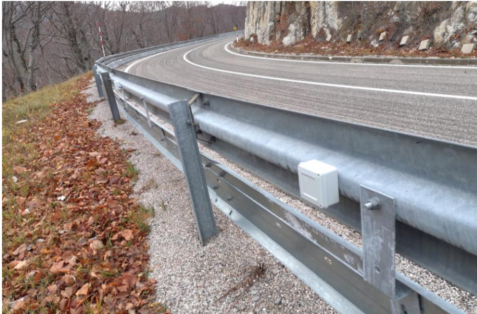
Slika 33. Senzor za detekciju udara na braniku ograde na DC25 Izvor: [68]
