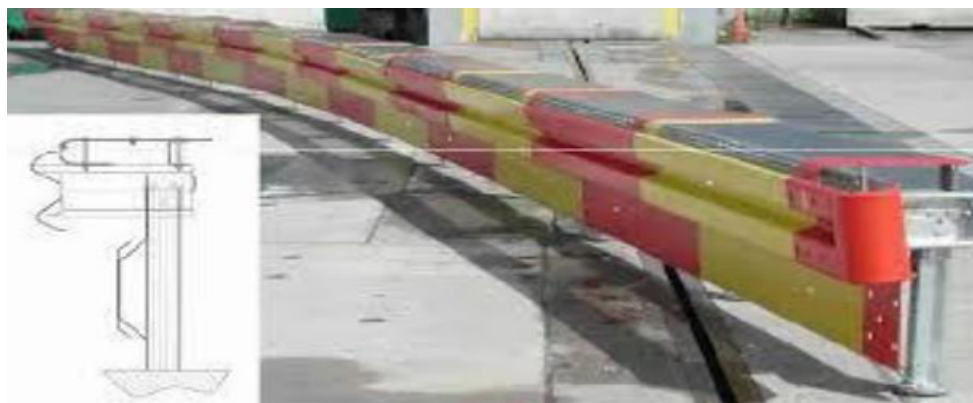
Slika 9: Prikaz gornjeg dodatka na zaštitnu ogradu
