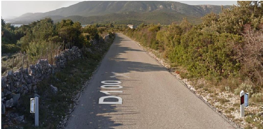
Slika 35: Prikaz smjerokaznih stupića s reflektorem za odvraćanje divljači
