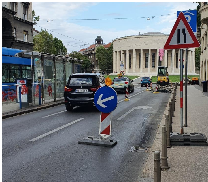
Slika 65. Prometna signalizacija na mjestu radova
