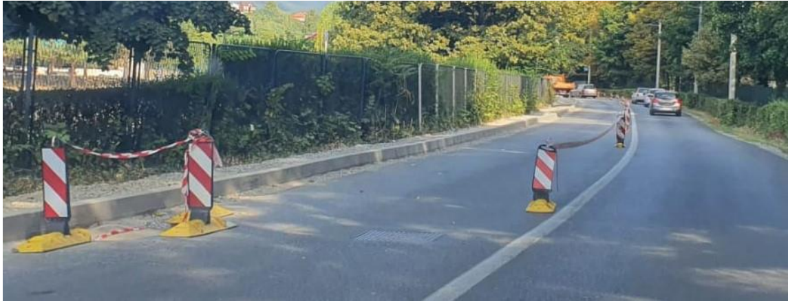
Slika 74. Početak markera za razdvajanje smjerova vožnje (K22-1)
