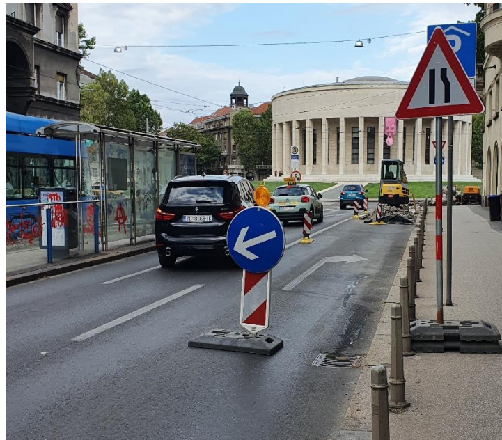
Slika 65. Prometna signalizacija na mjestu radova
