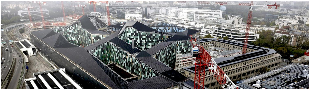
Slika 9. Postrojenje i infrastruktura tvrtke Bouygues sa sjedištem u Parizu, Francuska; [Izvor: 16]
