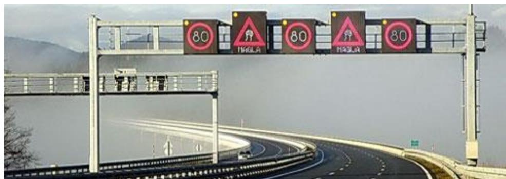
Slika 1. Promjenjiva signalizacija na autocesti [10]
