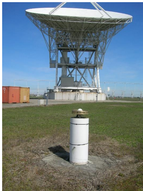
Slika 18. Bazna stanica u Medici
