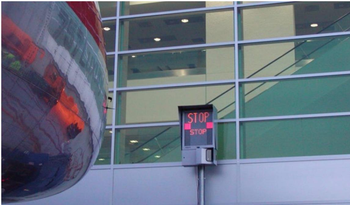
**Slika 35.** Sustav za navođenje zrakoplova
