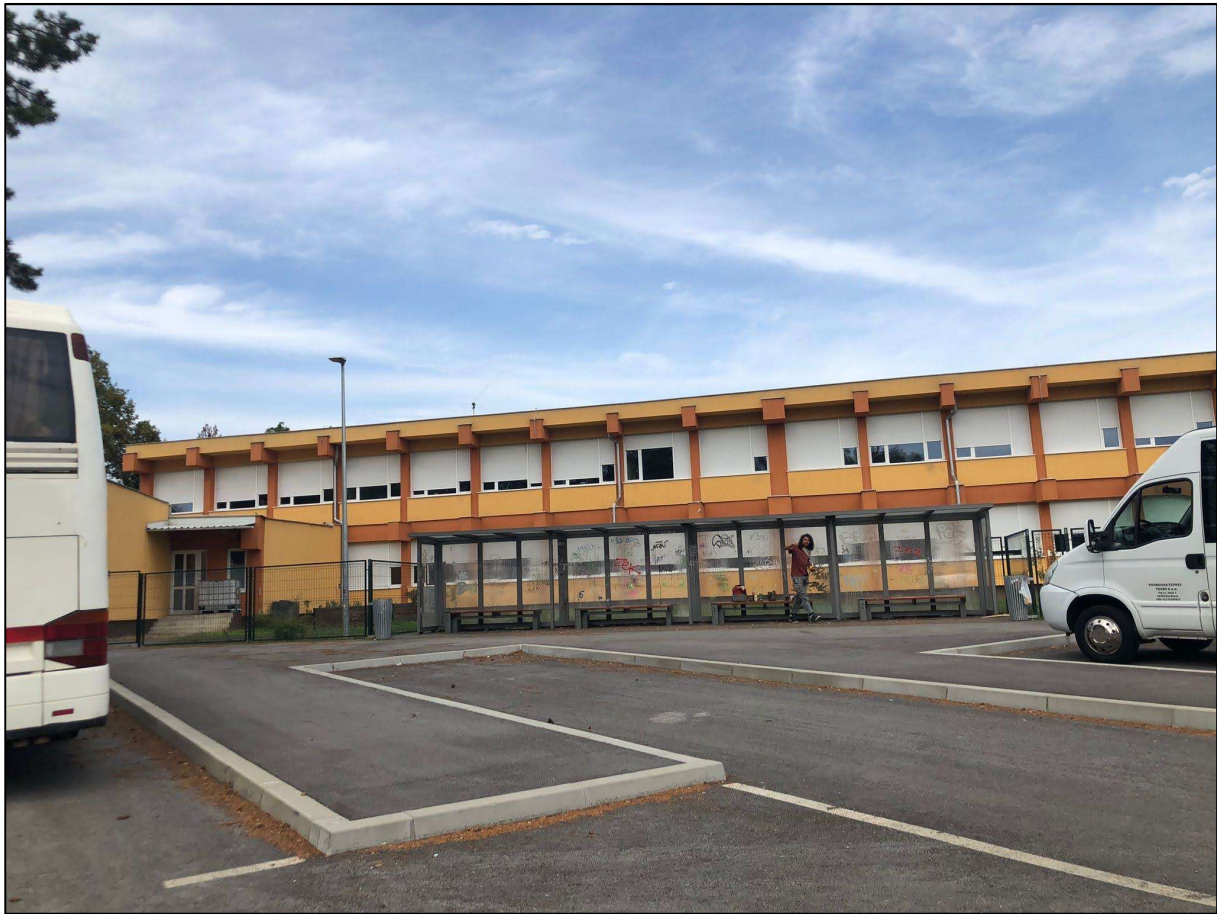
Slika 13: Autobusna stanica osnovne škole 'Ljubo Babić' u Jastrebarskom
