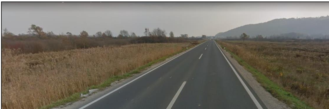
Slika 23. Dionica državne ceste DC 231 između Samobora i Svete Nedelje
