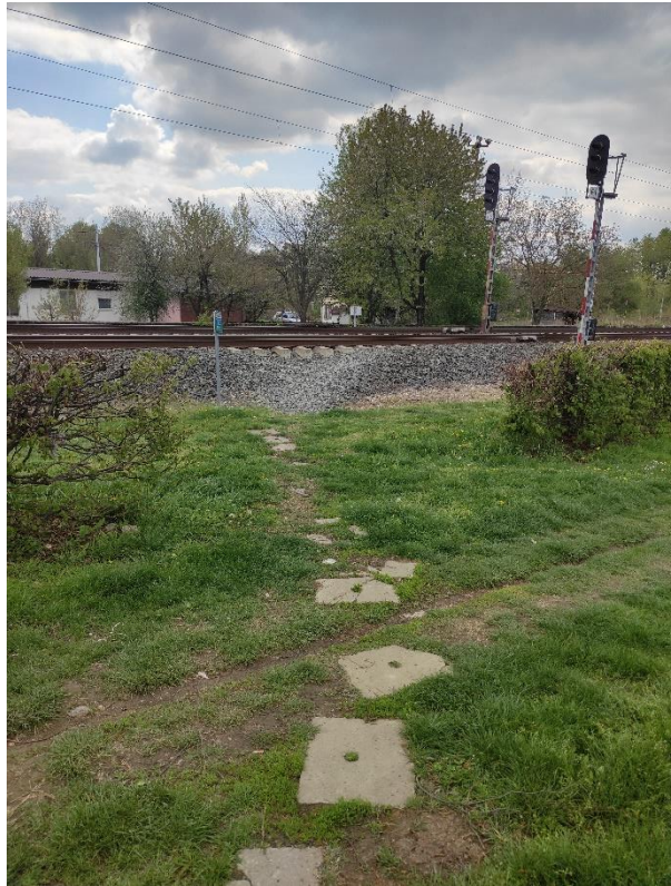
Slika 31 Lokacija 16 - „divlji“ prijelaz [24]
