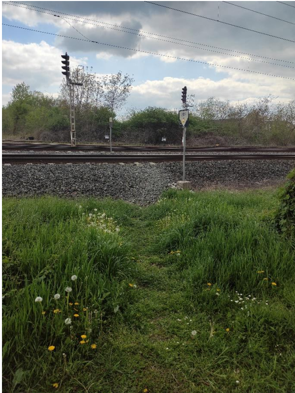
Slika 30 Lokacija 15 - „divlji“ prijelaz [24]
