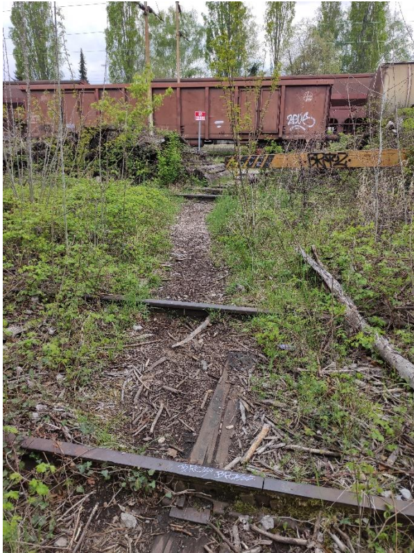
Slika 16 Lokacija 2 – „divlji“ prijelaz [24]
