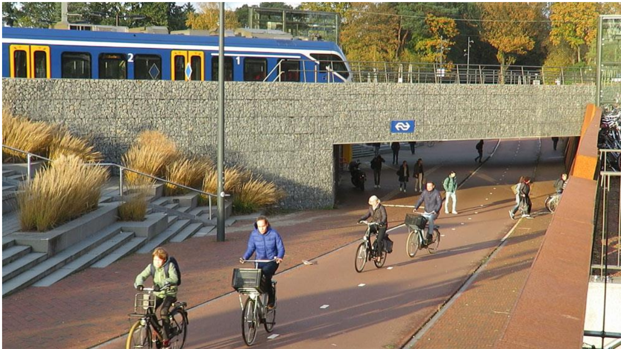
Slika 46 Primjer pješačko-biciklističkog pothodnika izgrađenog u Nizozemskoj [26]
