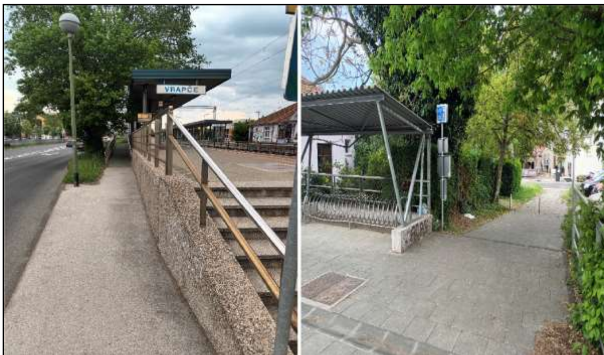
Slika 29. Rampa R1 (lijevo) i rampa R2 (desno)
