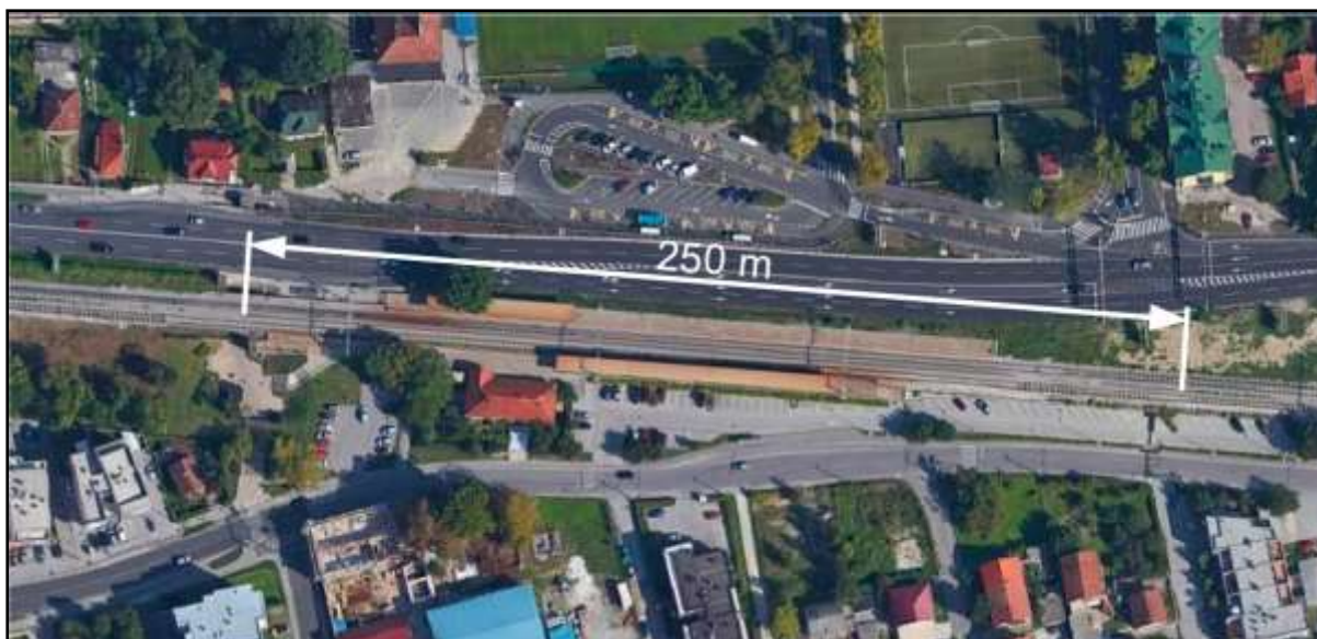
Slika 34. Udaljenost od zapadne lokacije na kojoj nastaju ilegalni prijelazi preko pruge do pothodnika
