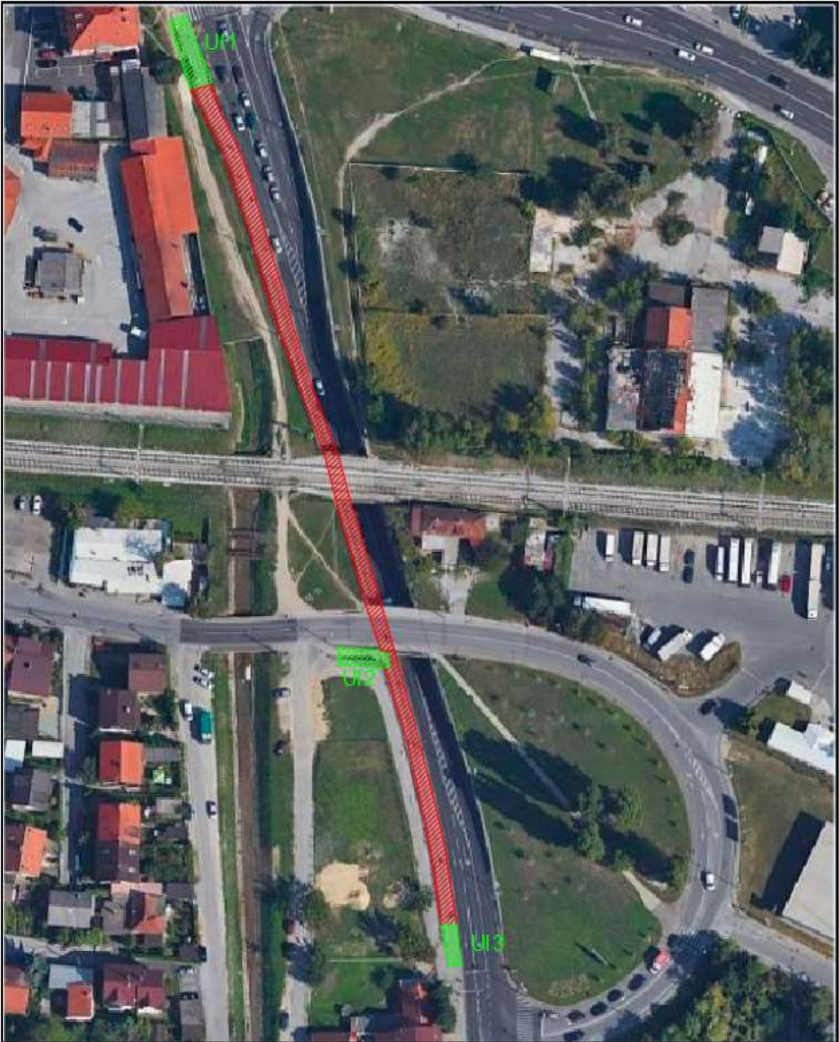
Slika 26. Pothodnik na istočnoj lokaciji
