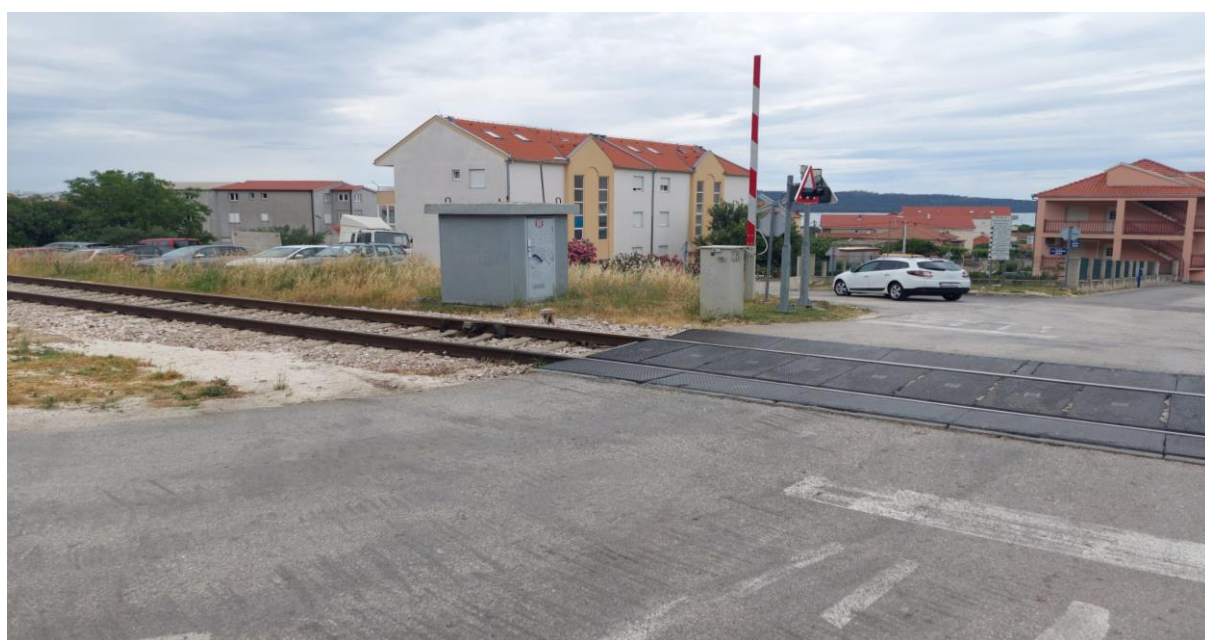
Slika 69. Željezničko-cestovni prijelaz „Kaštel Gomilica“ iz smjera istoka
