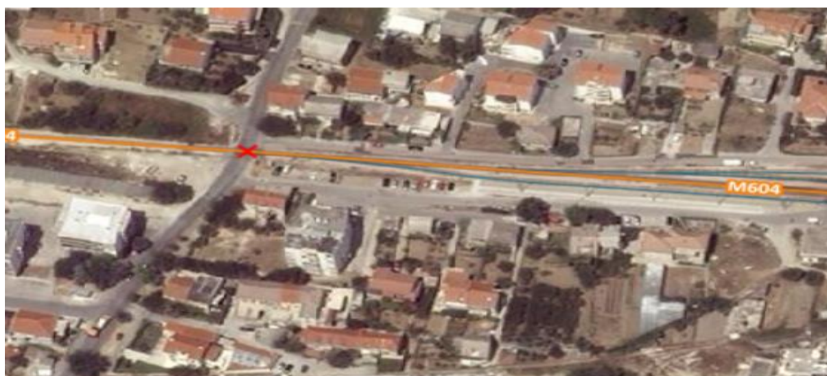
Slika 76. Željezničko-cestovni prijelaz „Kaštel Sućurac“
