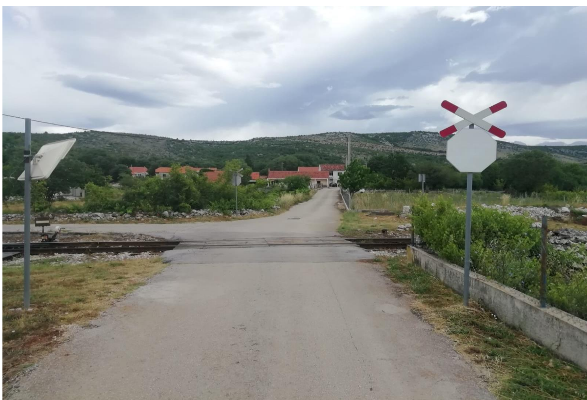
Slika 21. Željezničko-cestovni prijelaz „Stojaci“ iz smjera zapada
