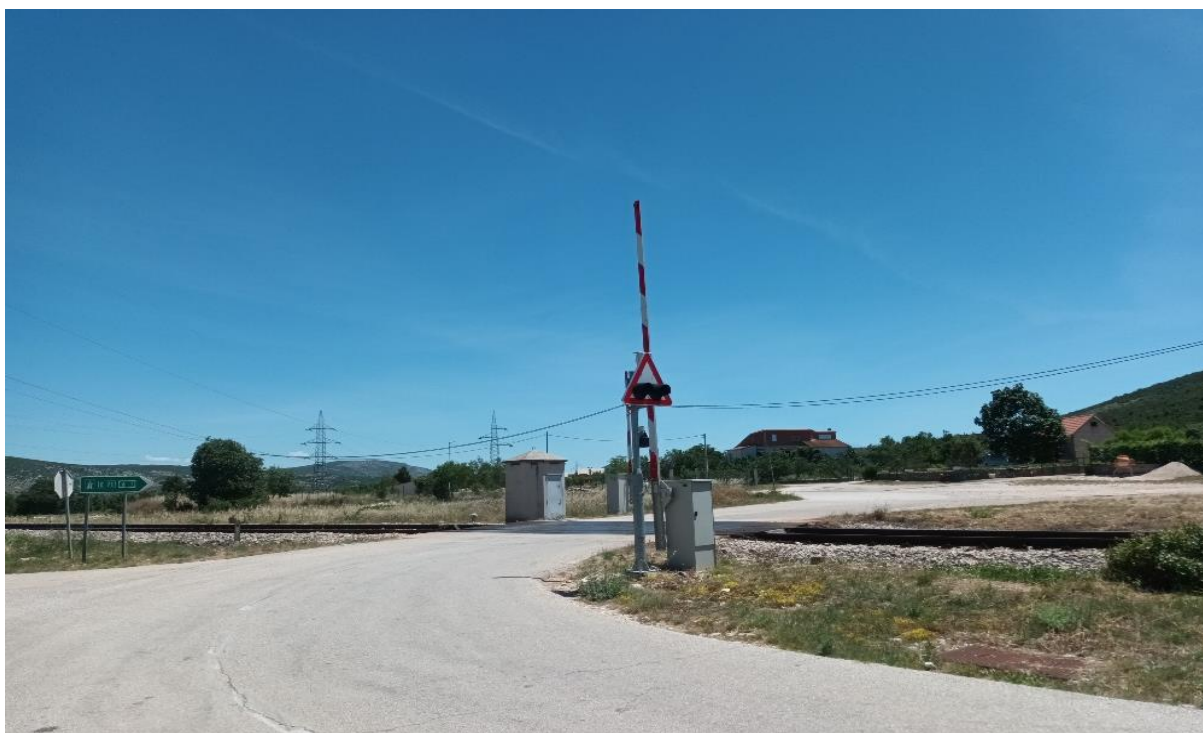
Slika 9. Željezničko-cestovni prijelaz „Perkovići“ iz smjera zapada
