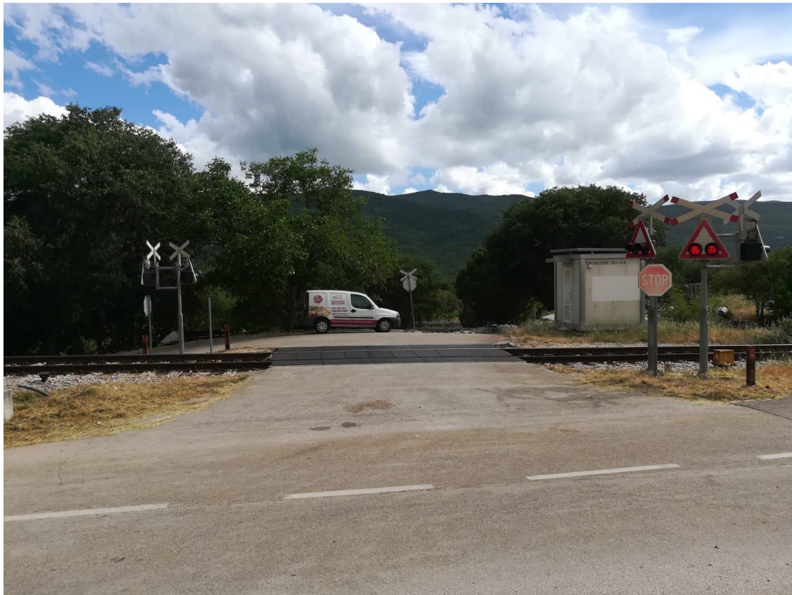
Slika 3. Željezničko-cestovni prijelaz osiguran sa svjetlosno-zvučnom signalizacijom i "Andrijinim križem", Fratrov Izvor: Autor
