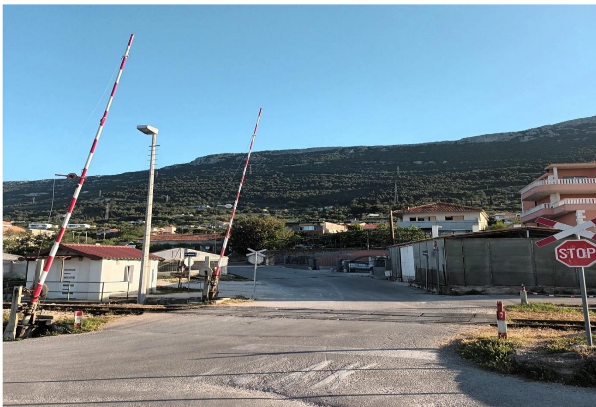
Slika 5. Željezničko-cestovni prijelaz osiguran punim branicima, Kaštel Stari 1
