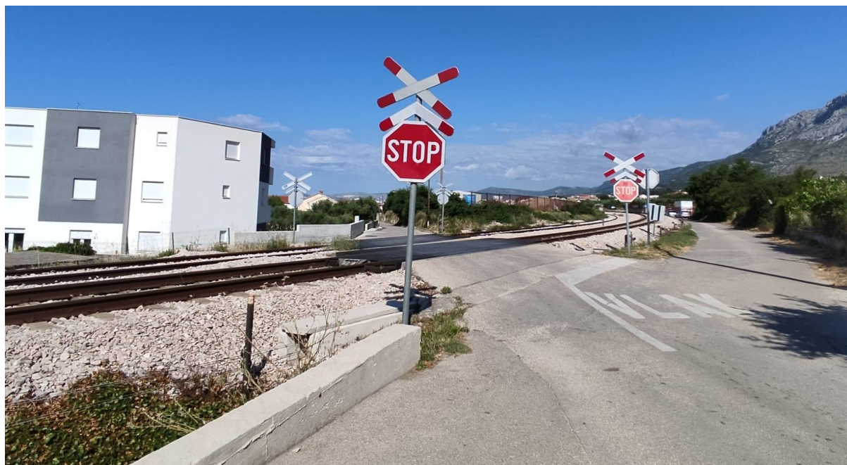
Slika 81. Željezničko-cestovni prijelaz „Kaštel Sućurac II“ iz smjera istoka
