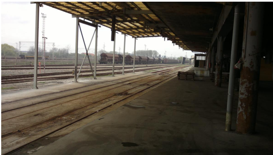
Slika 12. Rampa za utovar mineralnog gnojiva u željezničke vagone
