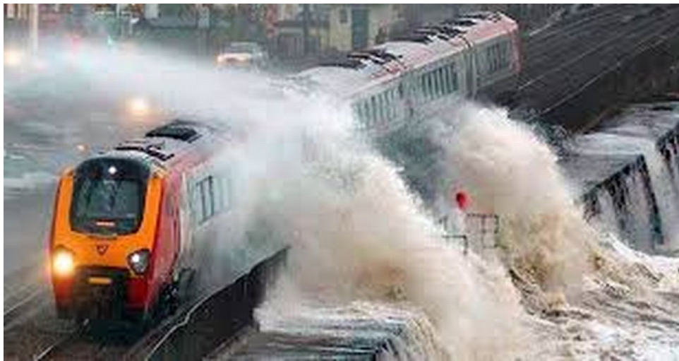
Slika 15. Zbog iznenadnih olujnih naleta vjetra i poplave zaustavljanje prometovanja vlaka na trasi Totnesa – Plymoutha, UK [61].
