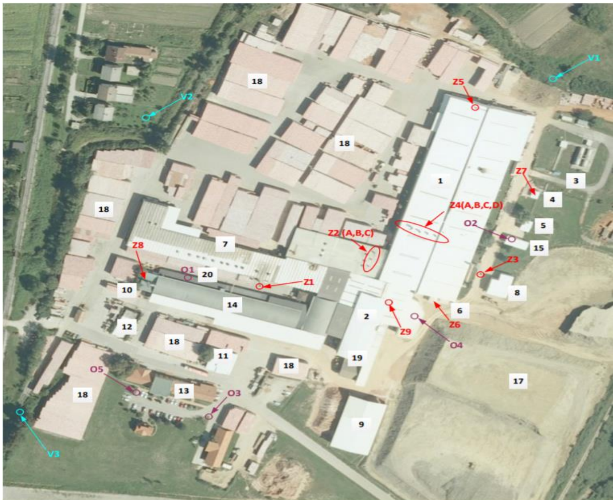
Slika 22: Wienerberger kompleks s označenim objektima
