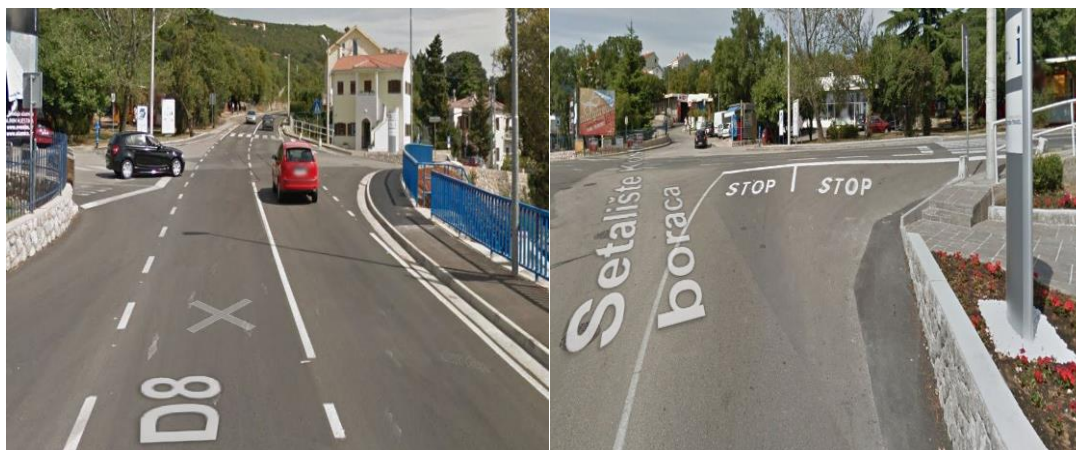
Slika 21. OM Šodići – prije sanacije
