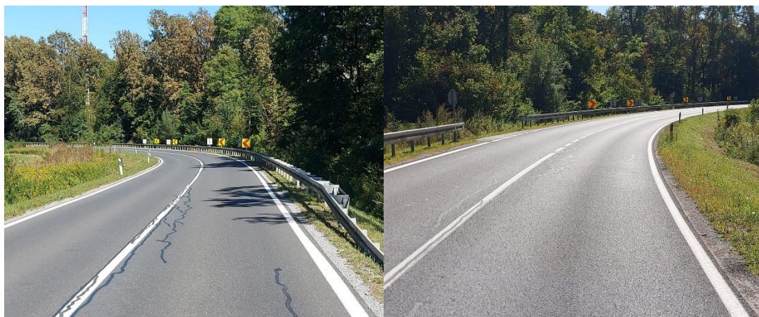
Slika 16. OM Šuma Brezovica – poslije sanacije Izvor: autor
