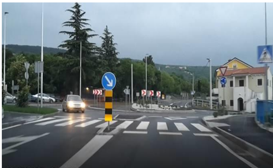
Slika 22. OM Šodići – poslije sanacije Izvor: autor
