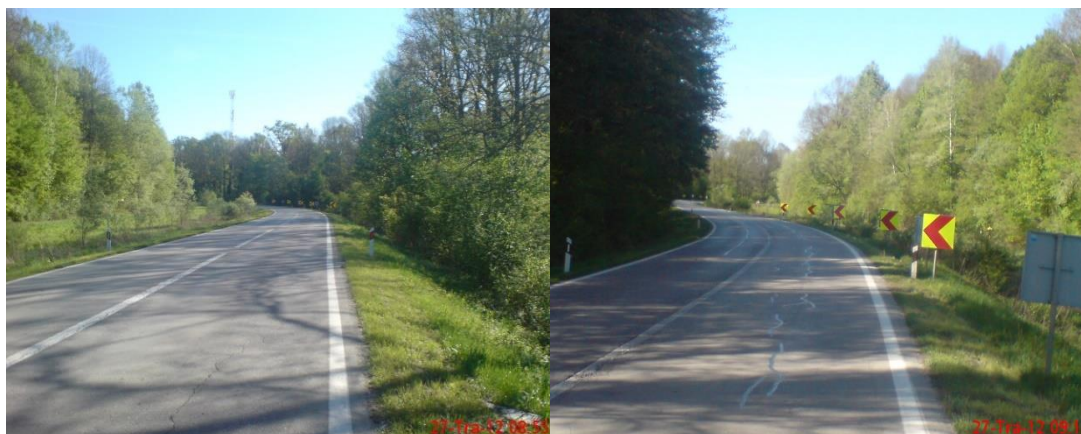
Slika 15. OM Šuma Brezovica – prije sanacije
