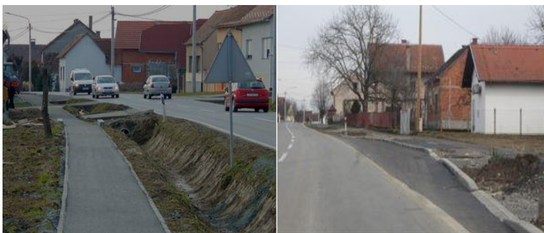
Slika 28. OM Eminovci – poslije sanacije
