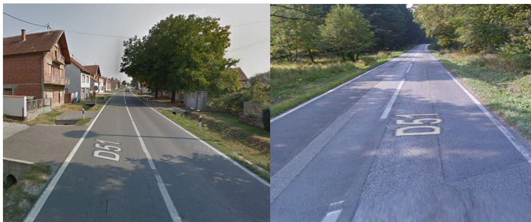
Slika 27. OM Eminovci – prije sanacije
