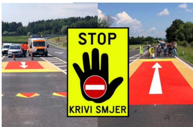
Slika 7. 3D signalizacija za pogrešan smjer na autocestama
